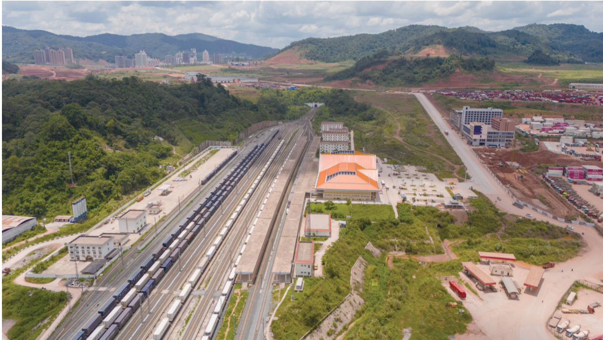
这是6月3日拍摄的中老铁路老挝段磨丁站全景（无人机照片）。近日，中老铁路老挝段磨丁站正式开启改扩建施工。这是中老铁路自2021年12月通车运营以来，老挝段内首次大规模扩能改造，将有效提升口岸车站接发列车与跨境货运集散能力。新华社发（凯乔摄）
