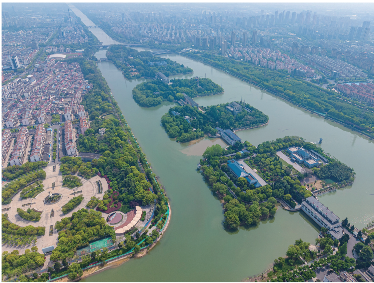
4月27日拍摄的位于江苏省扬州市江都区的南水北调东线源头江都水利枢纽(无人机照片)。4月27日10时，根据南水北调东线一期工程2026年4月水量调度方案，江苏省江都水利枢纽工程管理处启动新一轮调水，南水北调宝应站同步启动调水。新华社发(任飞摄)
