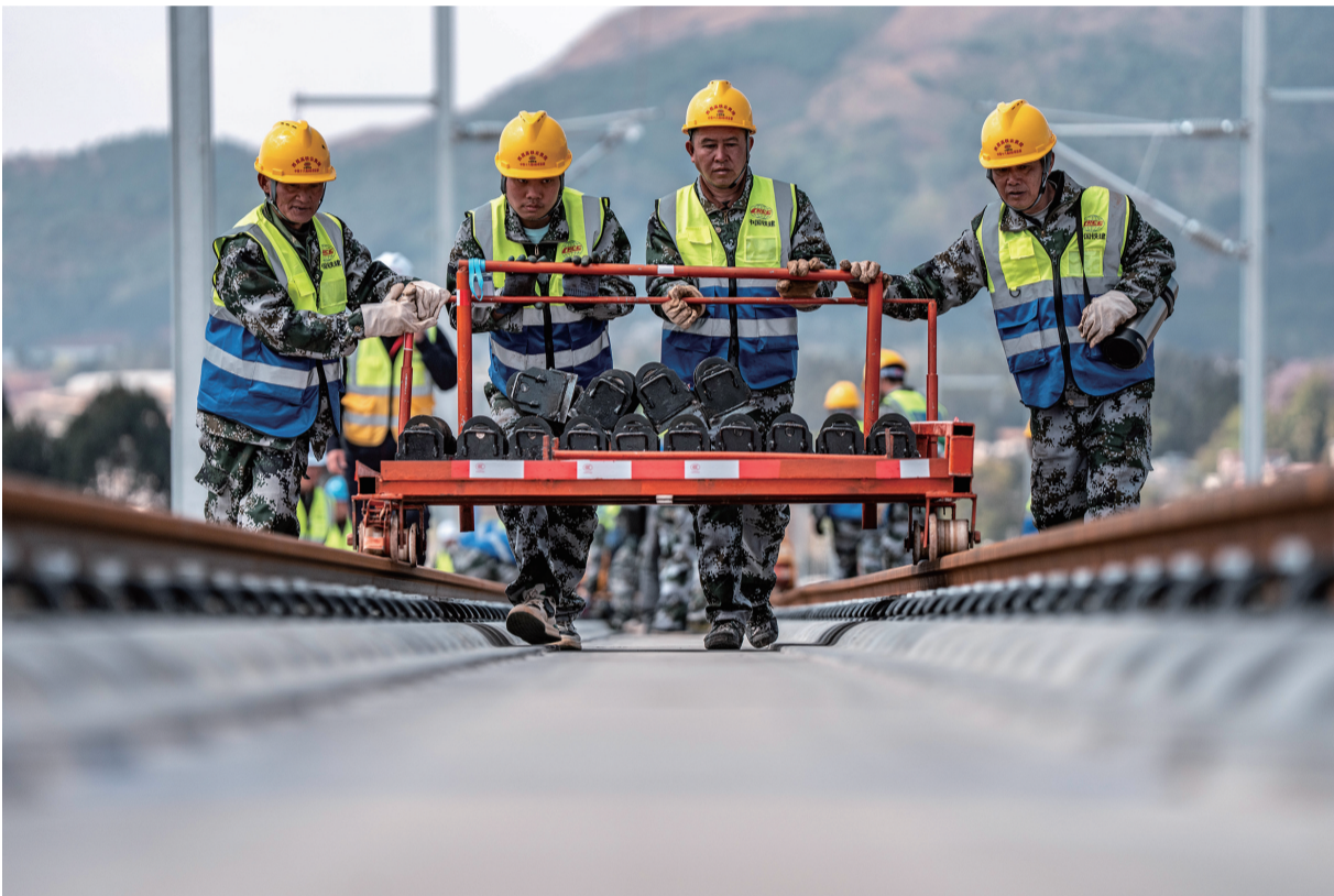
3月18日，工人在渝昆高铁施工现场进行铺轨作业。 3月18日，在位于云南省昆明市嵩明县的渝昆高铁施工现场，第一对500米长钢轨稳稳落在无砟轨道上，渝昆高铁云南段正式开始铺轨。 渝昆高铁是我国“八纵八横”高铁网京昆通道的重要组成部分，线路开通运营后，重庆到昆明的行车时间将压缩至两个半小时左右。
