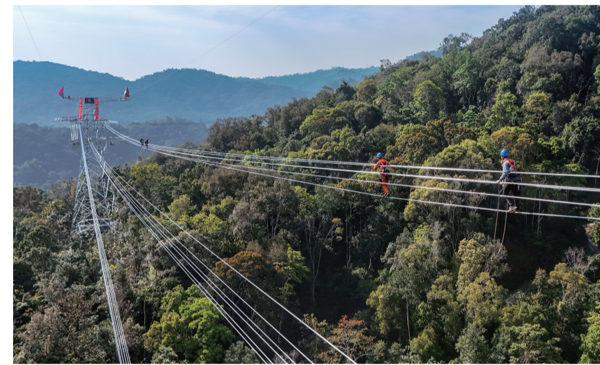
2月5日，施工人员分别从位于中国和老挝境内的铁塔相向出发，前往线路连接点汇合(无人机照片)。
