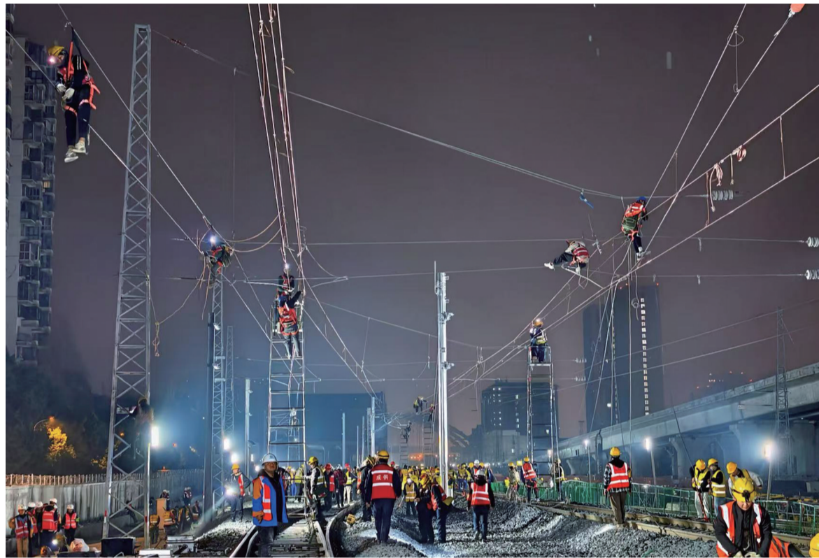
1月16日，中铁电气化局施工人员进行接触网施工。 1月16日凌晨，成都八里站在车站持续运营基础上完成关键过渡改造，将成都站至八里站区间的既有成渝线、达成线拨接至新建东环线线位，同步对成都站、八里站、客机整备所等进行了系统性适应性改造，标志着成渝中线建设迈出关键一步。 成都八里站前身为1952年建成投用的成都东站，曾是成都铁路枢纽至关重要的主编组站和主货运站。 新华社发（李向雨 摄）
