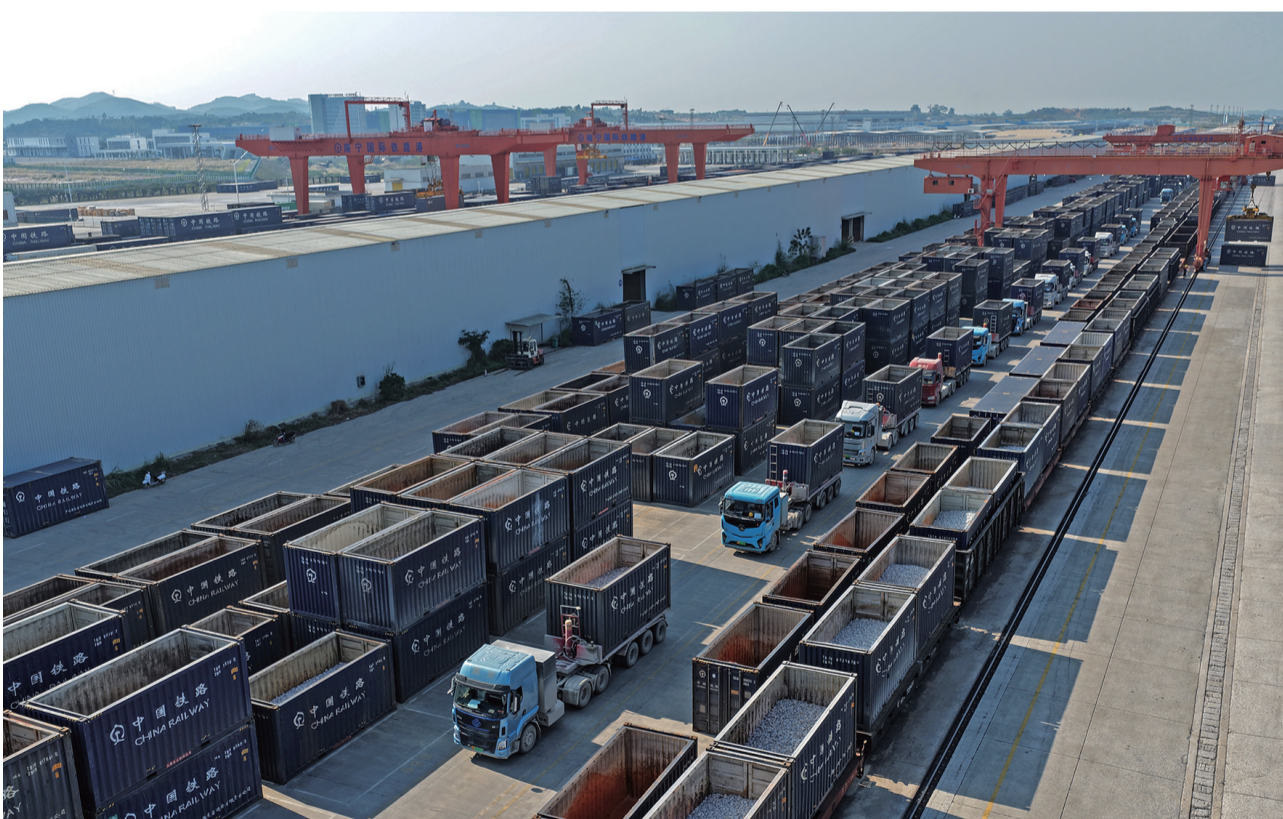
这是2026年1月8日拍摄的南宁国际铁路港(无人机照片)。
