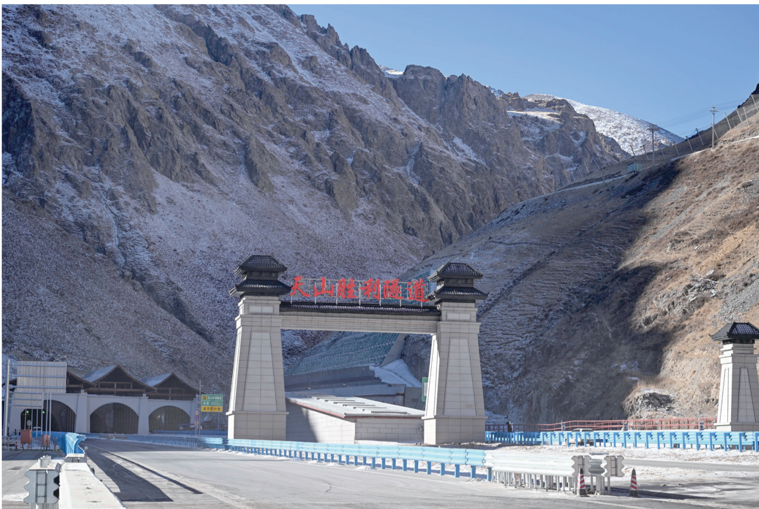
新疆乌尉高速公路天山胜利隧道入口端（12月23日摄）。
