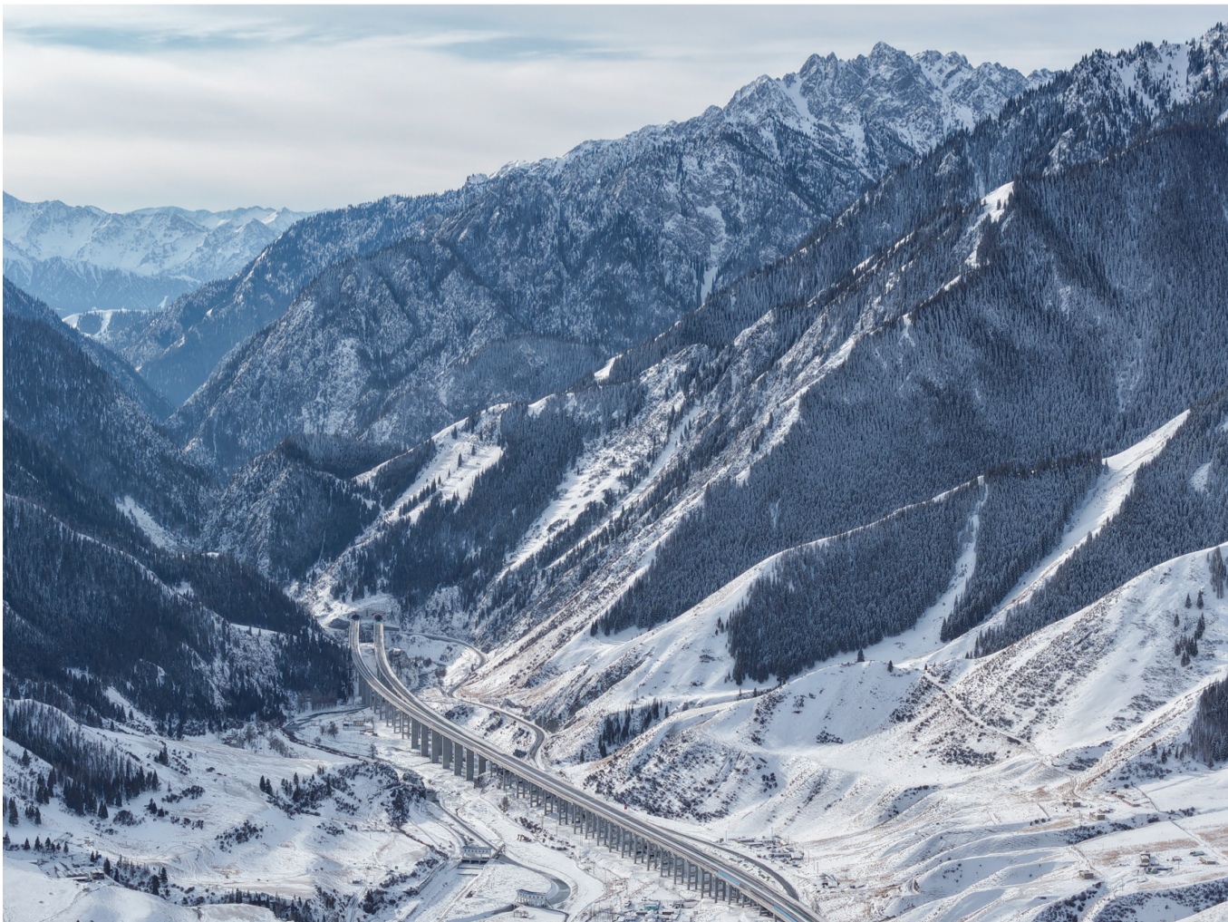
这是新疆乌尉高速公路前峡1号隧道及附近路段（12月20日摄，无人机照片）。
