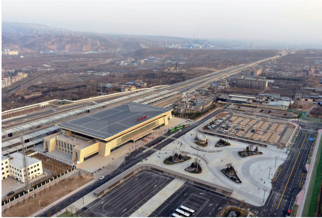
12月24日拍摄的西延高铁铜川站（无人机照片）。 记者12月24日从中国铁路集团有限公司获悉，西安至延安高铁将于12月26日开通运营，陕北革命老区将迈入“高铁时代”，为促进区域经济社会高质量发展注入新动能。 新华社记者 邢广利 摄
