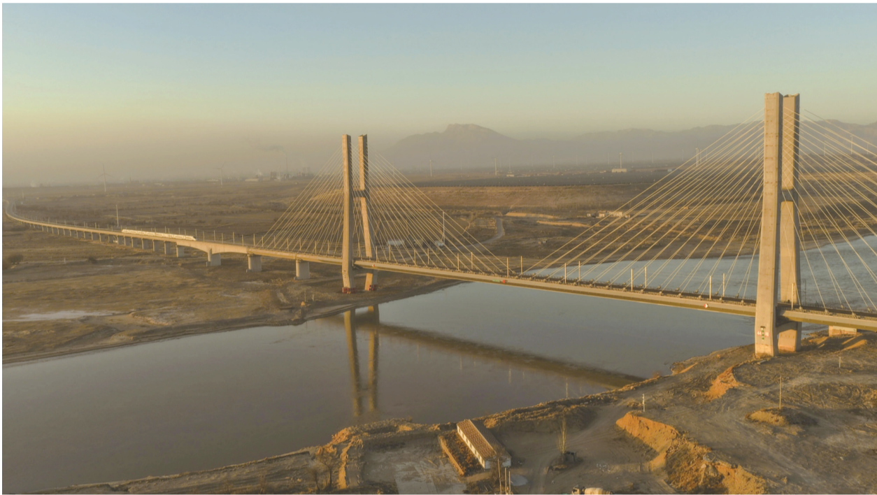
12月23日，列车驶过包银高铁乌海黄河特大桥。12月23日，包银高铁包惠段正式建成通车，包银高铁全线贯通运营，“八纵八横”高速铁路网京兰通道全线贯通，完善了西北地区高铁路网，为新时代西部大开发注入新动能。新华社记者 邢广利 摄
