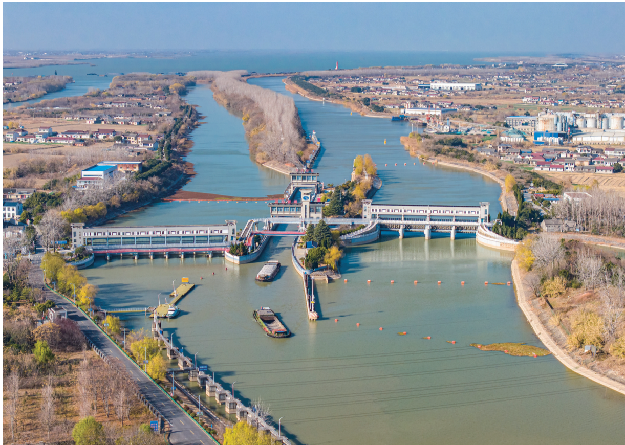
12月21日在江苏省扬州市江都区拍摄的南水北调东线一期工程运盐闸、邵仙套闸、邵仙闸洞（无人机照片）。新华社发（任飞摄）
