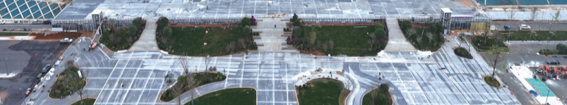
11月12日拍摄的盘兴高铁兴义南站（无人机照片）。
