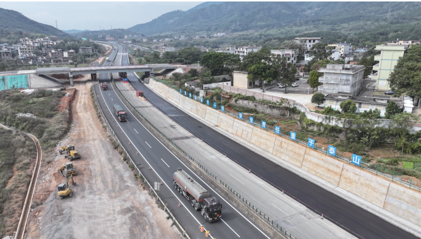
这是10月24日在京港澳高速未宜改扩建工程宜章段施工现场拍摄的宜章北枢纽互通（无人机照片）。近日，京港澳高速未宜改扩建工程宜章段右幅主线建设进入冲刺阶段，中建五局施工工人正抓紧铺沥青，为12月底如期拉通奠定基础。京港澳高速是连接中国南北交通的“大动脉”，其中未宜改扩建工程由中建五局投资建设，全长约27千米，是湖南省“四改八”高速公路改扩建项目，建成后 will 显著改善区域交通条件，促进经济社会发展。 新华社记者 丁春雨 摄
