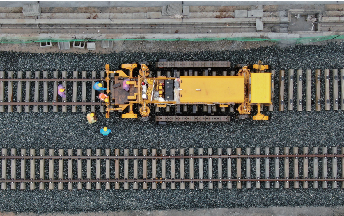
10月11日，中铁一局施工人员在西康高铁西安东站至牛背梁站区间铺设无缝钢轨（无人机照片）。
