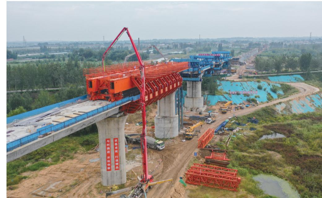
9月24日，在潍宿高铁山东段，中铁十四局施工人员在进行安丘汶河特大桥40米简支梁浇筑施工（无人机照片）。
