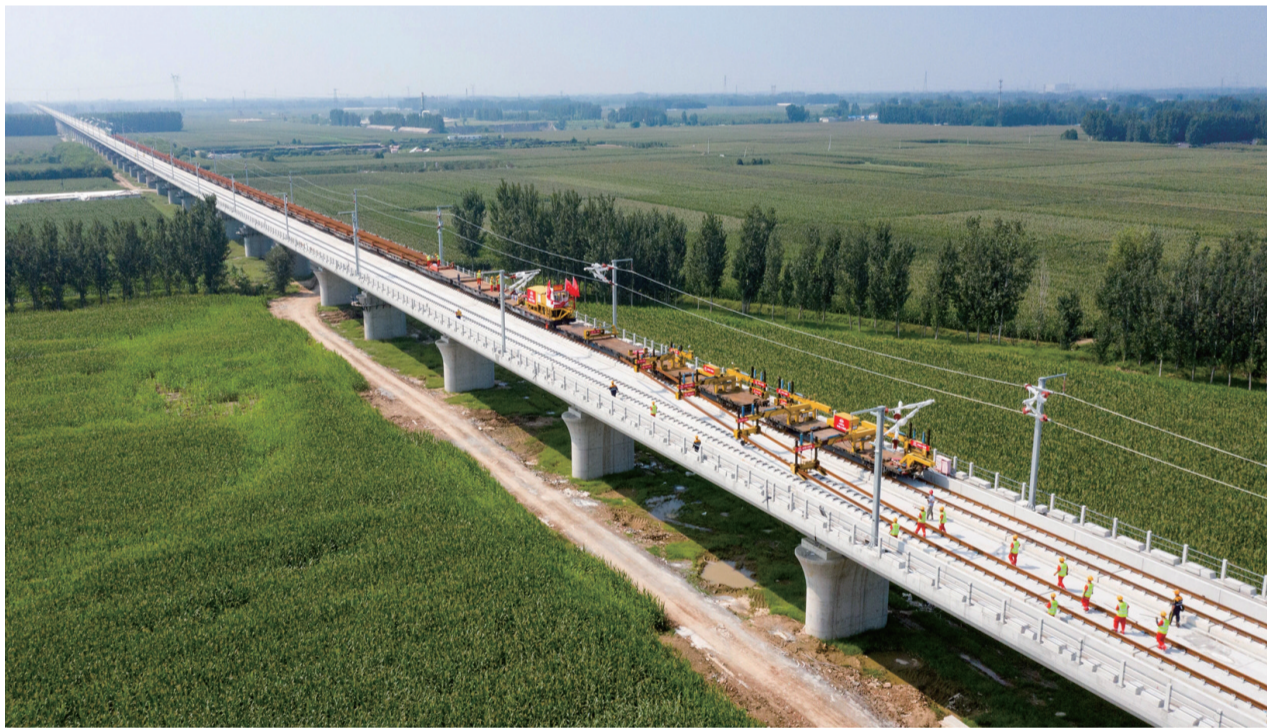
9月1日，工作人员在河北省河间市施工（无人机照片）。
