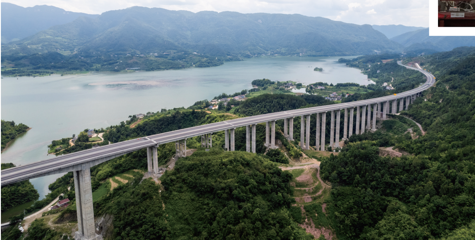
这是8月19日在湖南炉慈高速公路建设施工现场拍摄的金岭1号特大桥（无人机照片）。
