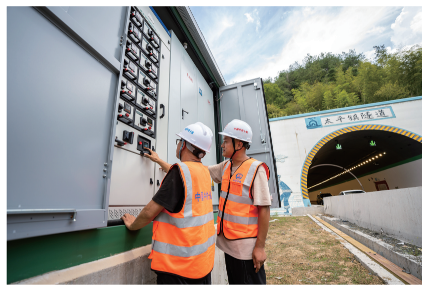
8月19日，在湖南炉慈高速太平镇隧道出入口，中铁十局技术人员调试隧道供电设备。
