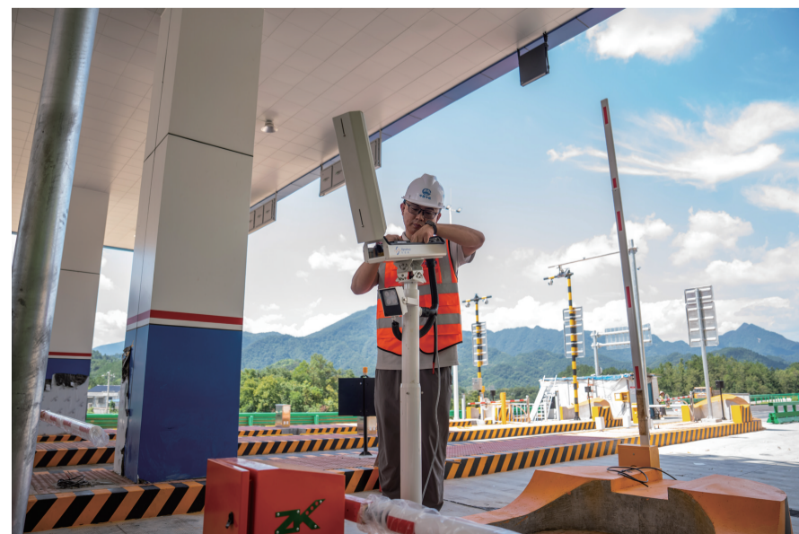
8月19日，在湖南炉慈高速维新收费站，中铁十局技术人员调试ETC设备。
