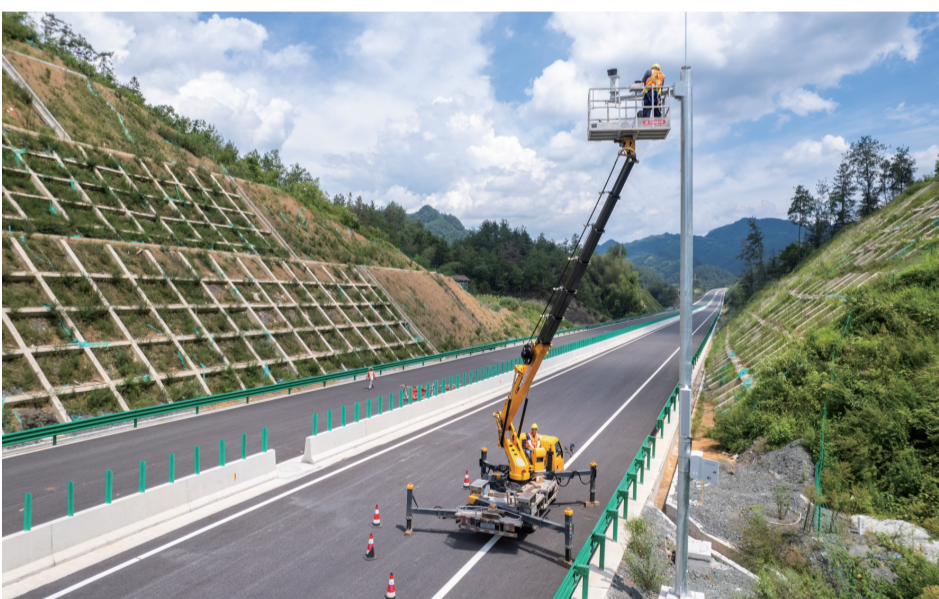
◀8月19日，在湖南炉慈高速公路建设施工现场，中铁十局技术人员安装路面监控设备（无人机照片）。
