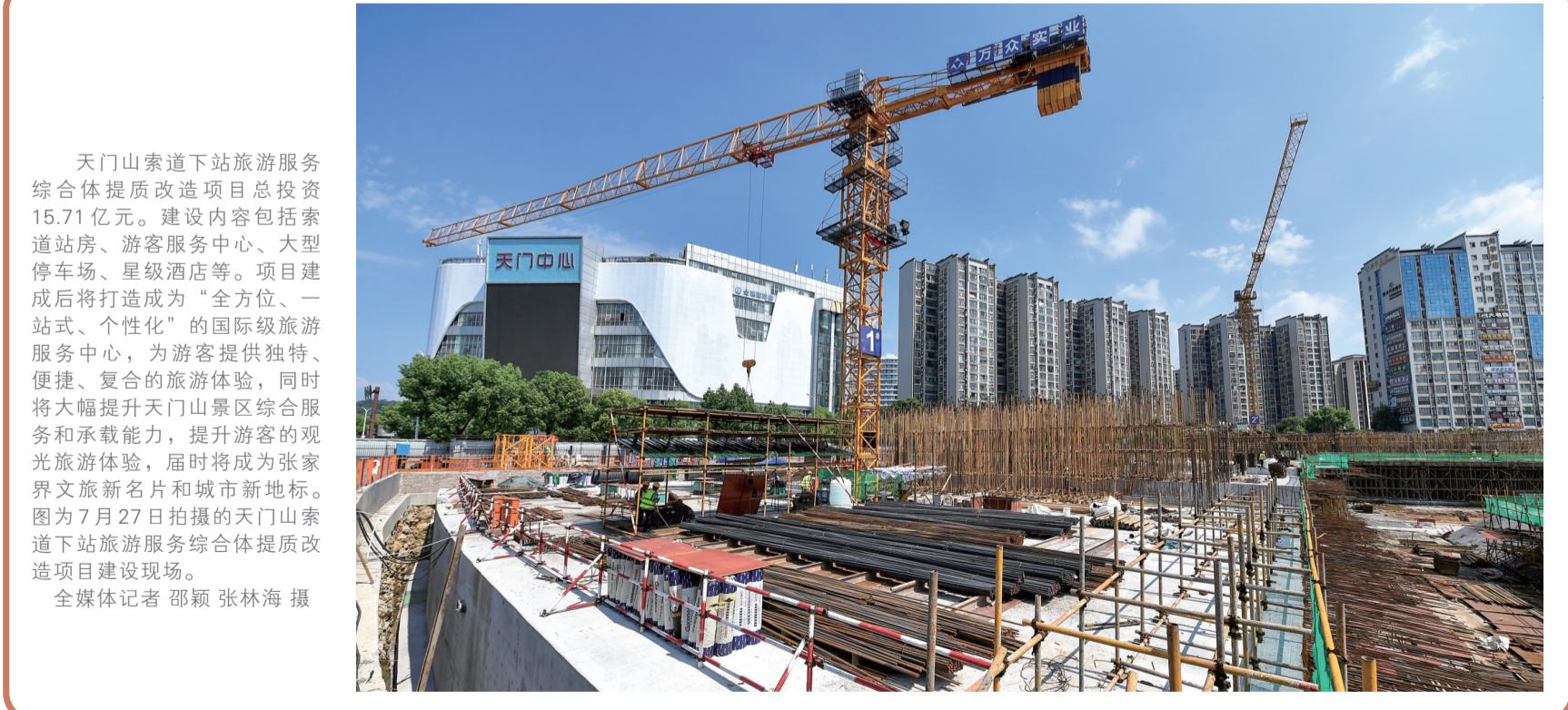
天门山索道下站旅游服务综合体提质改造项目总投资15.71亿元。建设内容包括索道站房、游客服务中心、大型停车场、星级酒店等。项目建成后，将打造成为“全方位、一站式、个性化”的国际级旅游服务中心，为游客提供独特、便捷、复合的旅游体验，同时将大幅提升天门山景区综合服务和承载能力，提升游客的观光旅游体验，届时将成为张家界文旅新名片和城市新地标。图为7月27日拍摄的天门山索道下站旅游服务综合体提质改造项目施工现场。邵颖 张林海 摄
