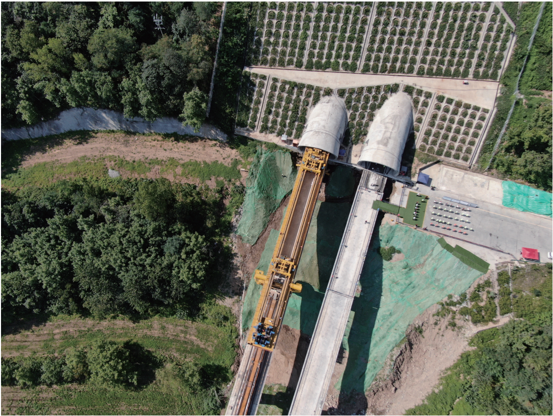
正在架设最后一孔箱梁的西康高铁跨关中环线立交特大桥（7月28日摄，无人机照片）。
