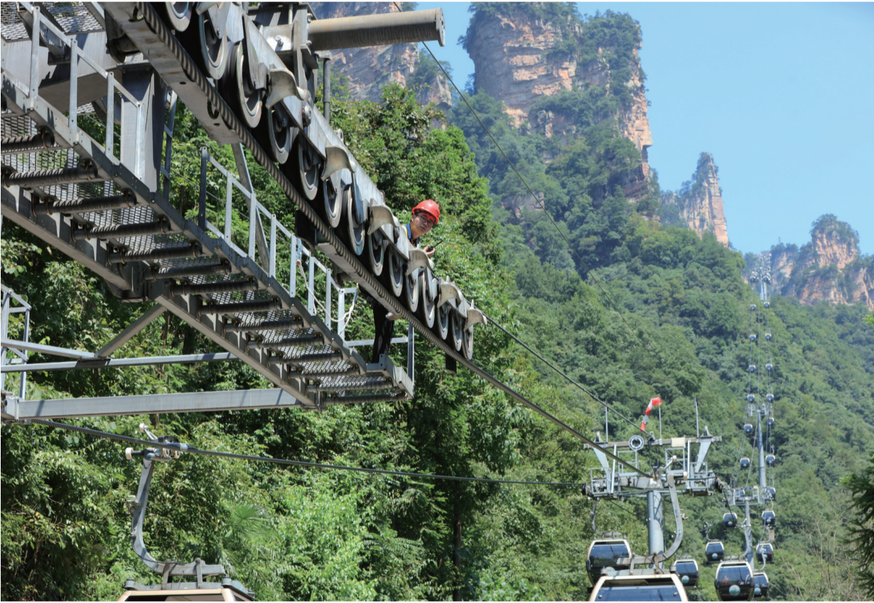
7月7日,张家界国家森林公园天子山索道技术工人对索道缆绳、轮组等进行安全检查和维护保养,及时排除安全隐患,保障高温天气索道正常运行。
