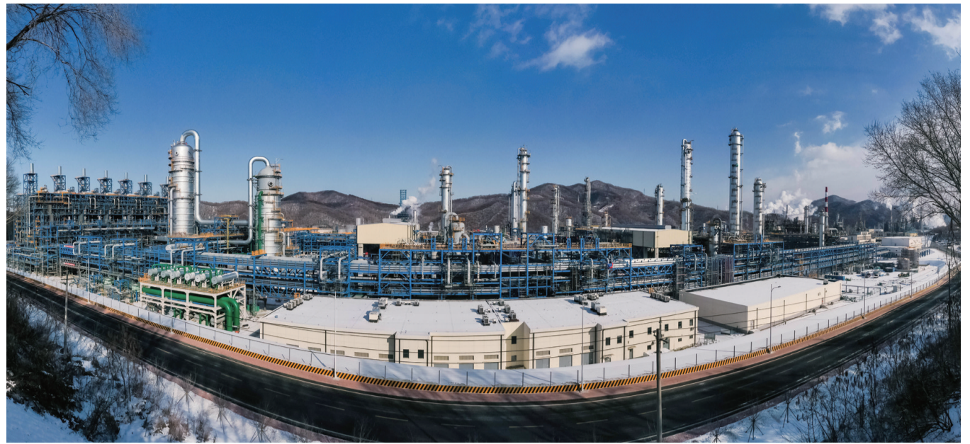
这是2025年2月12日拍摄的位于吉林省吉林市的中国石油吉林石化公司炼油化工转型升级项目120万吨/年乙烯装置建设现场（无人机照片）。 新华社记者 许畅
