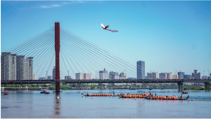
位于吉林市松花江上的临江门大桥（2024年6月10日摄）。 新华社记者 颜麟蕴 摄
