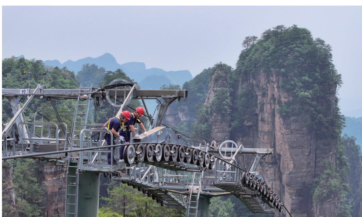
5月25日，张家界国家森林公园杨家界索道技术工人检查索道设备。随着端午假期临近，张家界国家森林公园也将迎来夏季旅游旺季。为保障游览安全，杨家界索道技术工人采取早、中、晚巡检的方式加大对高空索道缆绳、轮组等机件设备的安全运行检查和维护保养力度，及时排除安全隐患。
