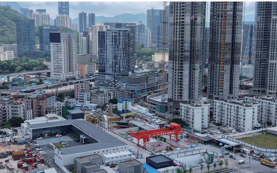
深汕铁路塘朗山隧道盾构始发井位于中心城区（5月14日摄，无人机照片）。由中铁上海局承建的深汕铁路塘朗山隧道日前开始盾构掘进，这台最大开挖直径达14.29米的超大直径土压/TBM双模盾构机将在深圳中心城区罗湖区地下掘进3.4千米。深汕铁路起于深圳西丽站，终至深汕特别合作区并引入广汕铁路深汕站，全长125.5千米。
