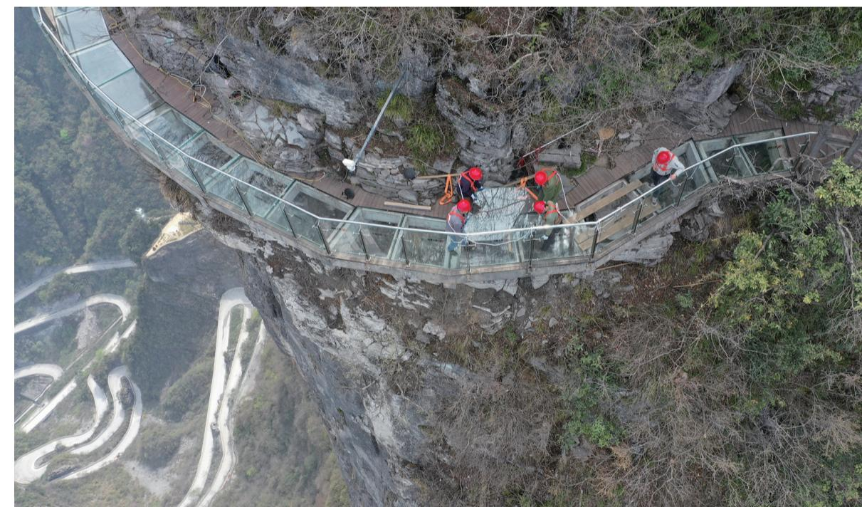
4月8日，施工人员在更换玻璃栈道的玻璃。当日，张家界天门山景区对盘龙崖玻璃栈道的27块玻璃进行更换，确保游客在安全舒适的环境中游览体验。此次更换的玻璃使用的是厚度为30毫米的抗弯曲能力强、耐冲击强度高的夹胶钢化玻璃。
