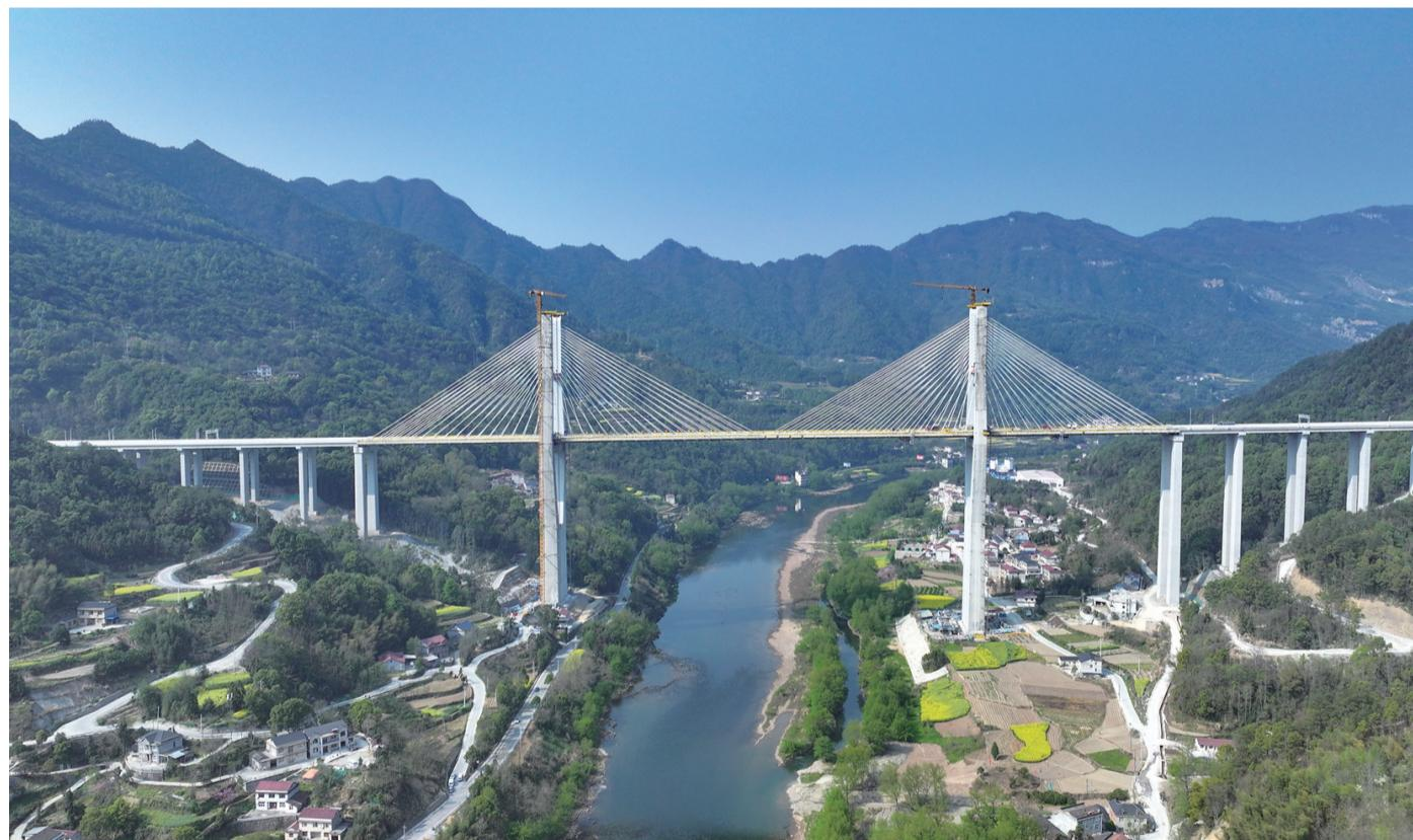
长潭河溇水特大桥是炉慈高速公路的控制性工程，大桥全长1060米，主跨280米，主塔高达211米，桥面距河面150米，为双塔双索面混凝土斜拉桥，被誉为“湘西第一高塔”。图为建设完工的长潭河溇水特大桥。
