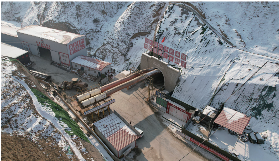
这是正在施工的兰合铁路考勒隧道2号斜井（12月17日摄，无人机照片）。 日前，由中铁二十局承建的兰合铁路考勒隧道掘进突破11000米，进入攻坚冲刺阶段。考勒隧道位于甘肃省临夏回族自治州东乡族自治县境内，全长14659米，隧道内土质结构主要为湿陷性黄土，地质构造复杂，是兰合铁路全线重难点控制性工程。 兰合铁路是国家中长期高速铁路网“八纵八横”的重要组成部分，新建正线全长147.42公里。 新华社记者 陈斌 摄
