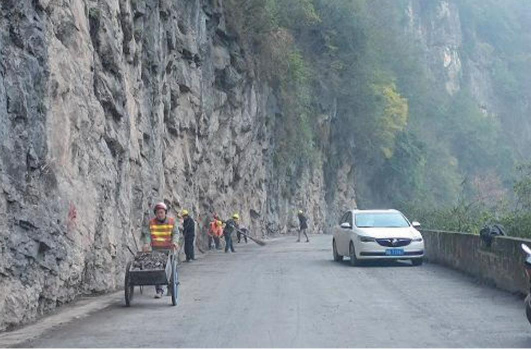
11月9日，慈利县S518道路路面破碎、路面冷再生正式完工，并顺利通过验收，即将进行下一道路沥青路面摊铺工作。此次大修工程主要包括路面破碎、冷再生、面层铺设等多个环节，旨在全面恢复并提高道路质量。
