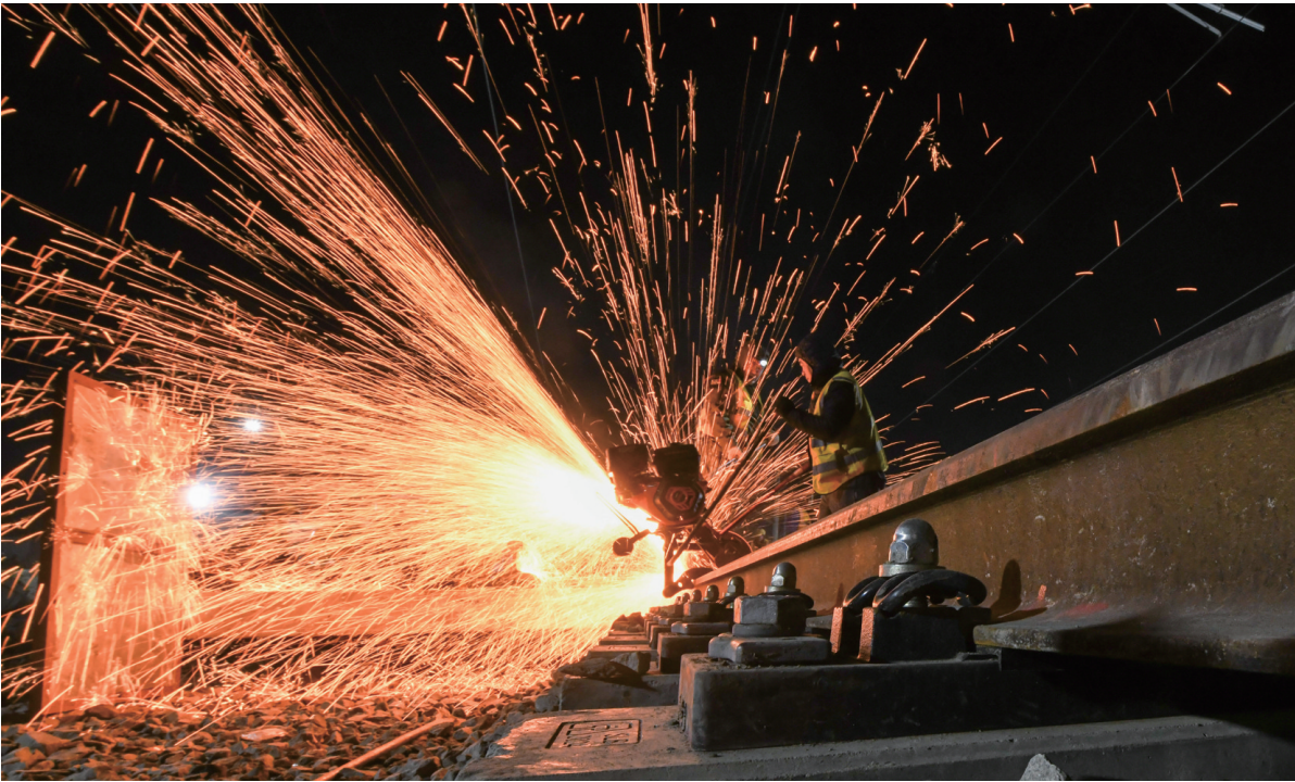
11月28日晚，工人在进行道岔铺设施工。 11月29日凌晨，经过中铁十二局360余人、200多台设备同步施工，新建沪渝蓉高铁汉口至宜昌段汉口至汉川东高桥线路所42号道岔完成铺铺，标志着沪渝蓉高铁与汉宜铁路实现互联互通。 此次铺铺的42号道岔全长157.2米，总重量达262吨，建设者经过8小时连续施工，拆除既有线路，并将两组42号道岔分别横移11米、纵移160米后完成铺设。
