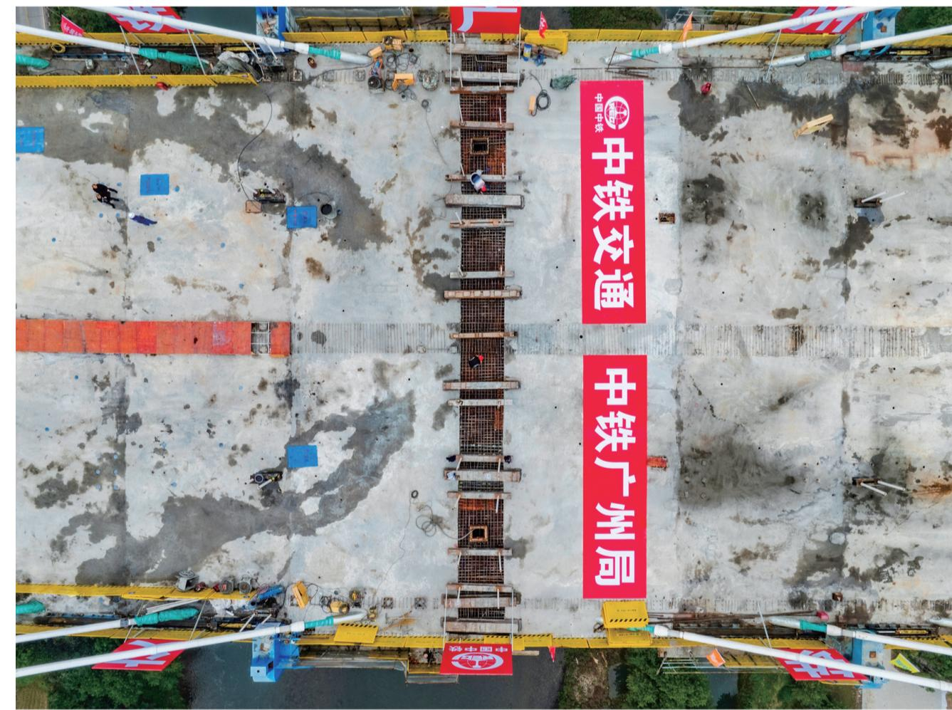
11月15日，由中铁交通投资集团投资、中铁二院设计、中铁广州工程局集团承建的湖南炉慈高速公路长潭河溇水特大桥合龙，标志着大桥主体工程完工，为项目按期建成通车奠定了坚实基础。该大桥是炉慈高速公路的控制性工程，位于我市慈利县零阳镇长潭河村，连接慈利隧道和尖峰岭隧道。大桥全长1060米，主跨280米，主塔高达211米，桥面距河面150米，为双塔双索面混凝土梁斜拉桥。大桥建设工艺要求高、施工区域地势险峻、环保要求严，是一座科技攻关型桥梁。
