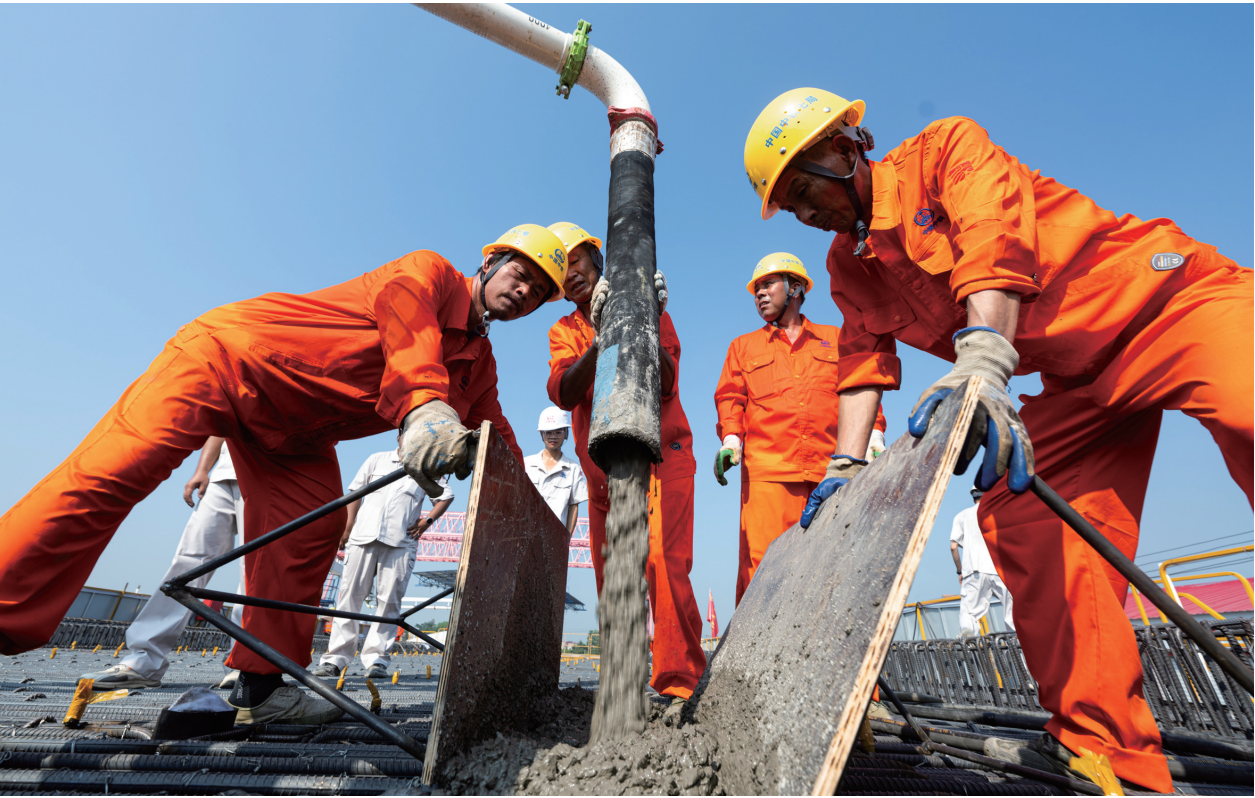
9月1日，中铁七局工人在合武高铁湖北段站前5标前川制梁场施工作业。
