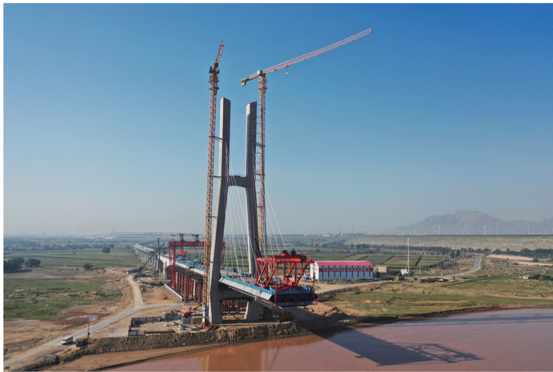
这是8月23日拍摄的包银高铁乌海黄河特大桥建设现场（无人机照片）。连日来，在包银高铁乌海黄河特大桥建设现场，工人们抓紧施工，确保工程建设进度。该工程位于内蒙古乌海市与宁夏石嘴山市交界处，是包银高铁重点控制性工程之一。包银高铁是我国“八纵八横”高速铁路网京兰通道的重要组成部分，设计时速250公里，计划2025年建成通车。 新华社记者 李志鹏 摄
