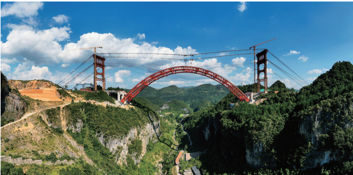
这是8月21日拍摄的贵阳至平塘高速公路马场河特大桥（无人机照片）。8月21日，由贵州桥梁集团承建的贵阳至平塘高速公路马场河特大桥主拱顺利合龙。马场河特大桥位于贵州省贵定县盘江镇马场河村，大桥全长381.5米、主跨260米，桥面设计为双向六车道，是G7522贵阳至北海高速公路贵阳至平塘段控制性工程。
