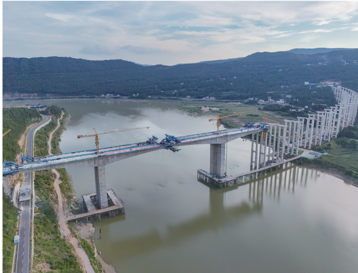
这是8月16日拍摄的京昆高速广元至绵阳段扩容工程嘉陵江特大桥（无人机照片）。当日，由中铁五局承建的京昆高速广元至绵阳段扩容工程全线最长桥嘉陵江特大桥连续梁右幅合龙，为全线建成通车奠定坚实基础。嘉陵江特大桥全桥长1555米，为双向六车道连续刚构桥。据了解，京昆高速广元至绵阳段扩容工程建成后，将使贯穿川陕的骨干公路流量进一步提升，使其成为成渝地区乃至我国西南地区通往华中、华北、京津冀的又一条快捷通道。 新华社记者 王曦 摄
