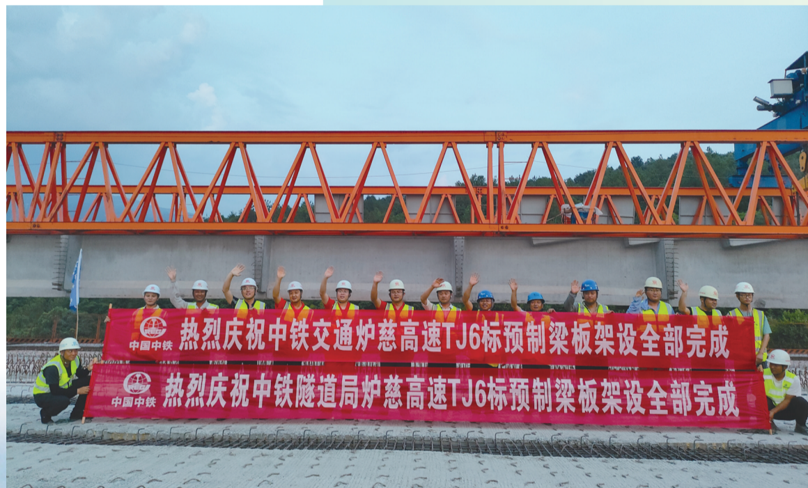
中铁隧道局集团有限公司炉慈高速公路六标最后一座桥梁完成架设，工作人员合影。
