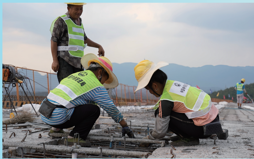
工人正在进行湿接缝加固作业。
