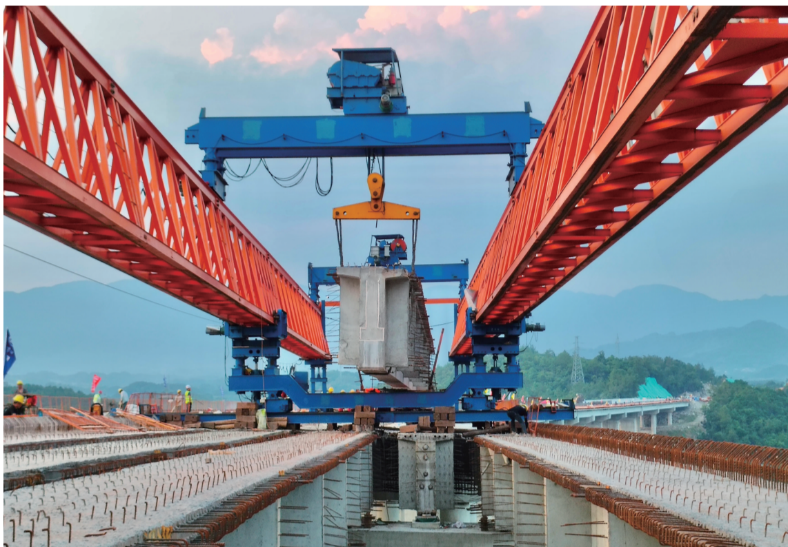
架桥机正在运送钢筋混凝土预制T梁。
