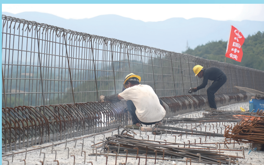
工人正在进行护栏钢筋焊接。
