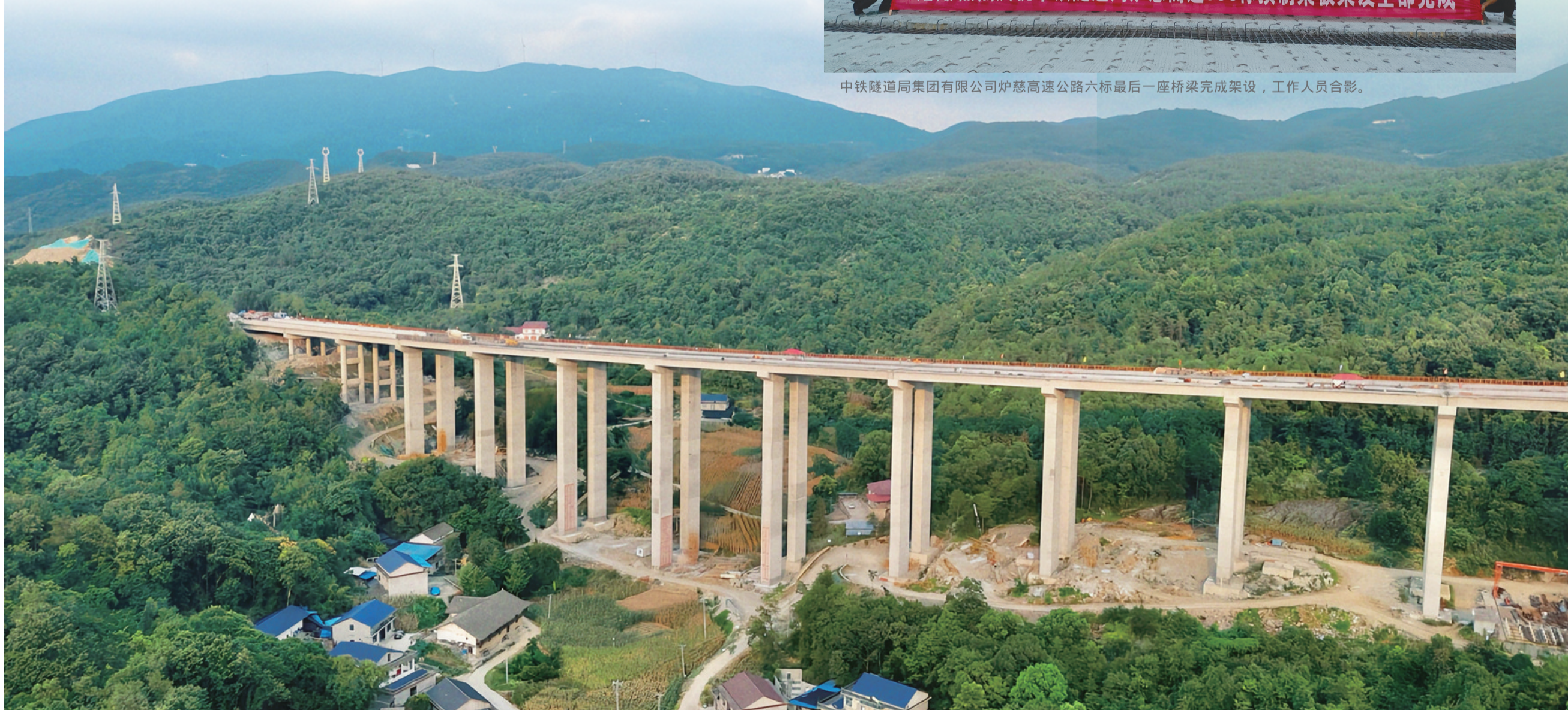
匡家峪大桥航拍全景。
