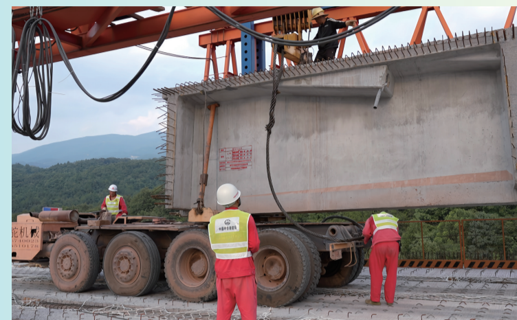
工人们正在进行T梁吊装作业。
