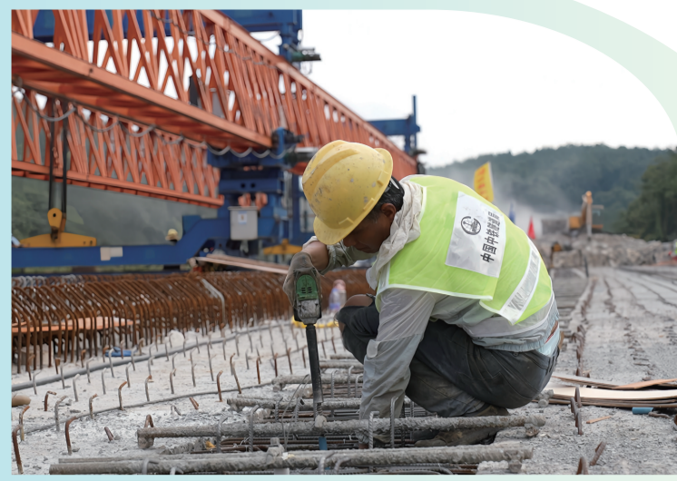
工人正在进行模板加固。
