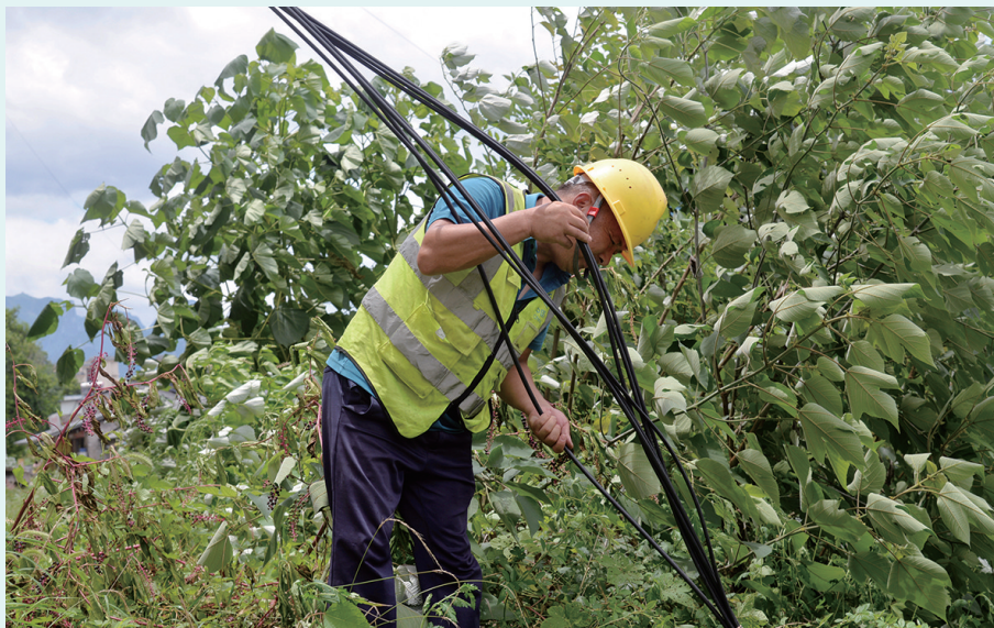
网络维护人员清理掉落的集挂光缆。
