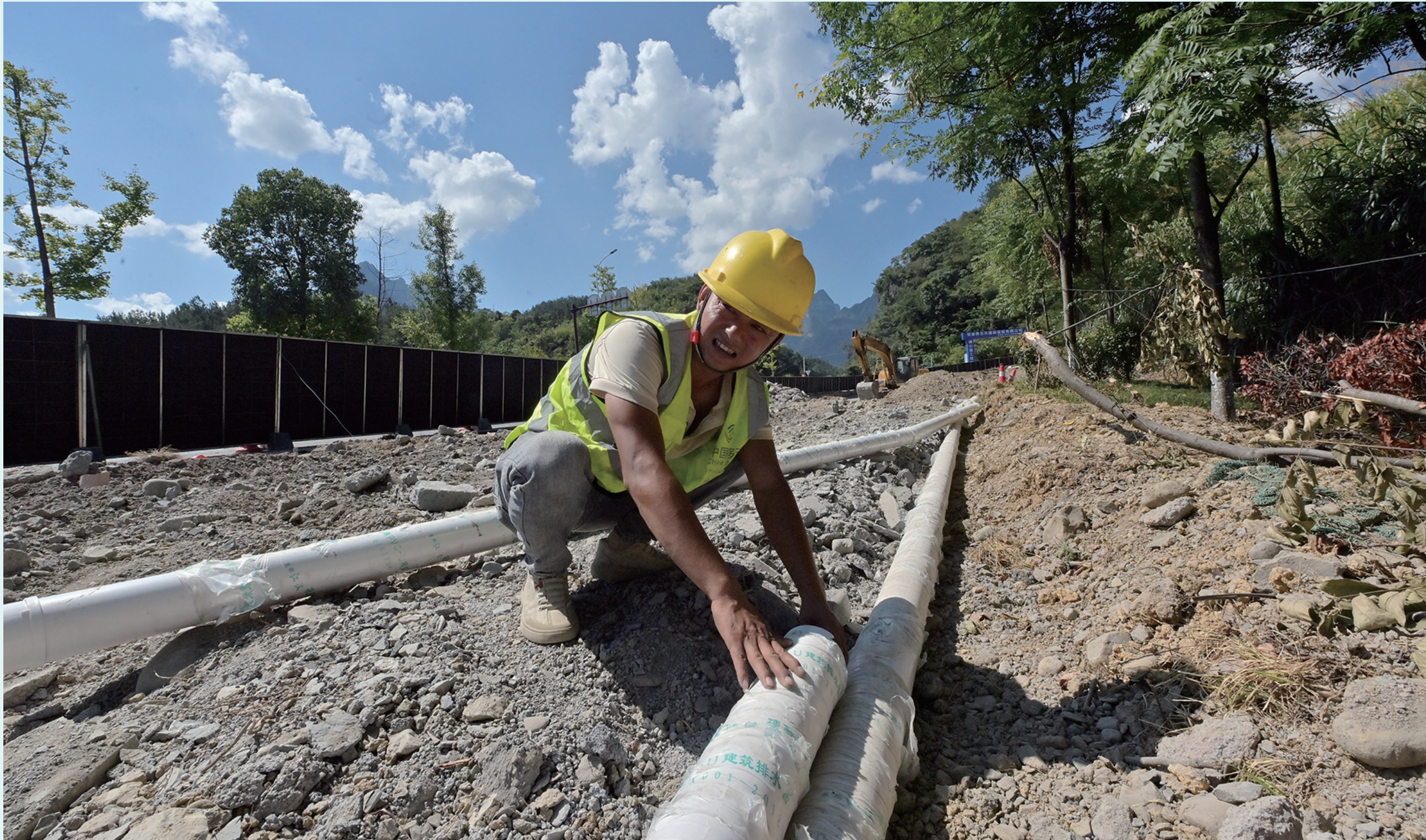
施工人员将修复后的弱电线穿入线缆管中。
