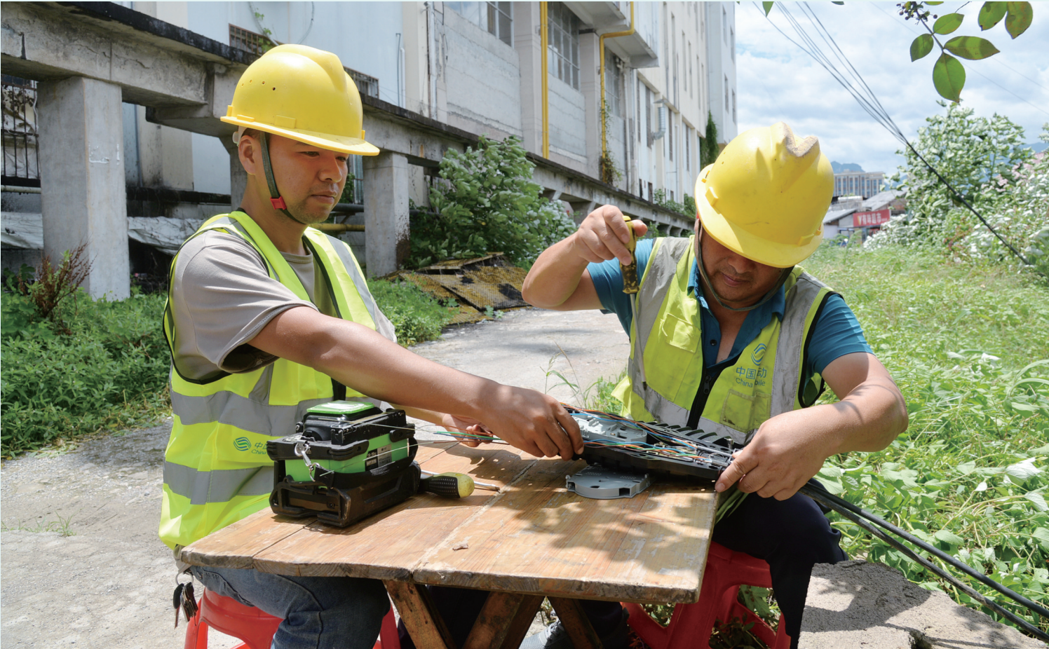
网络维护人员对传输光缆进行熔纤续接。
