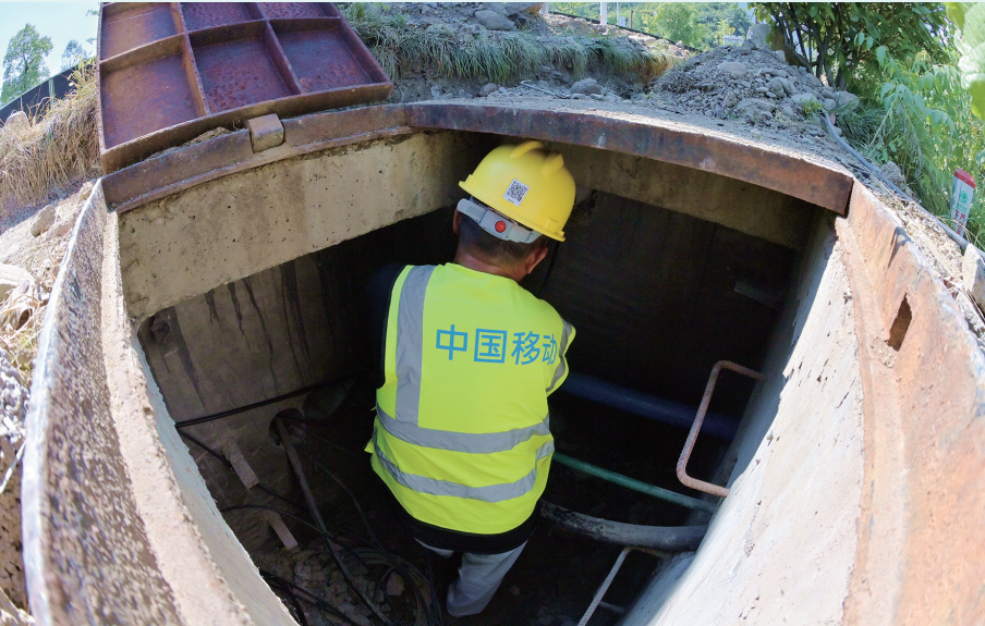
网络保障人员进行井下弱电线路整理整治施工。
