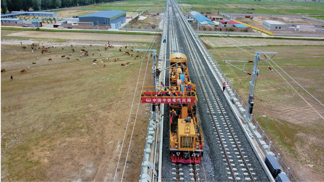
集大原高铁首批接触线成功架设
