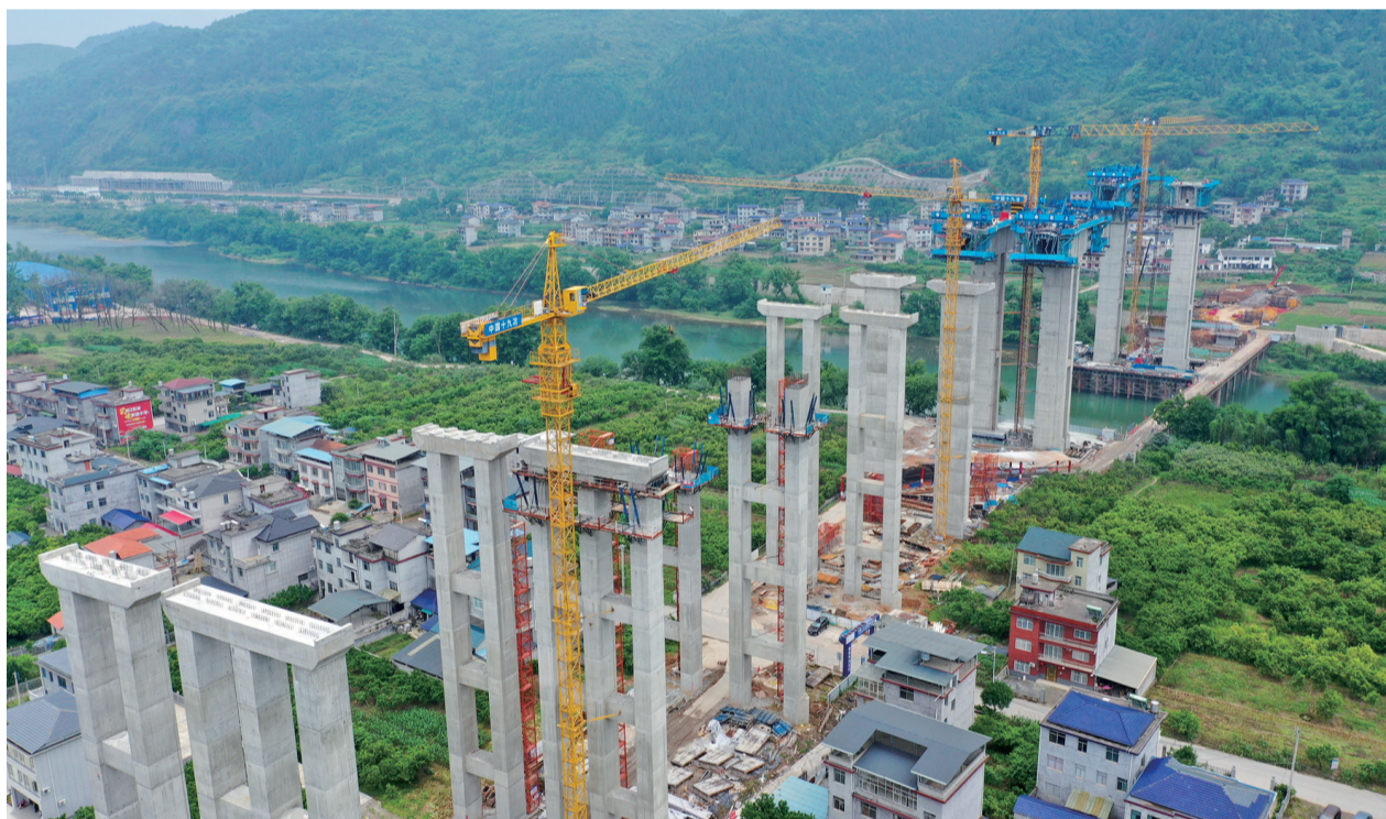
施工现场。全媒体记者 邵颖 刘子京 摄
