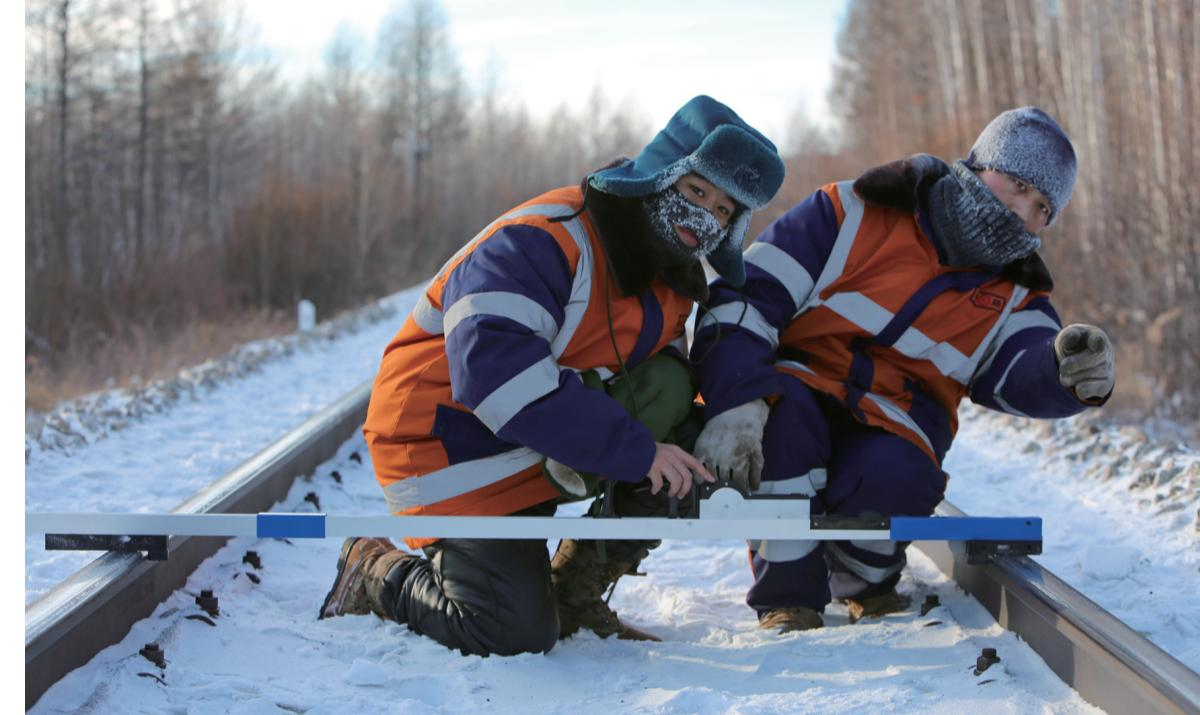
12月20日，在中国铁路哈尔滨局加格达奇工务段，漠河车间职工在现场测量，确认铁路轨道冻胀情况。
