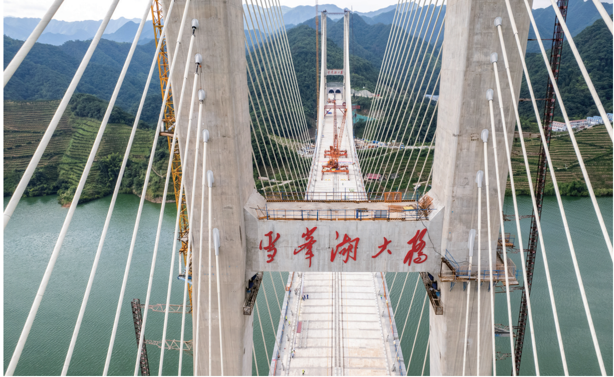
7月7日,湖南官新高速雪峰湖大桥施工现场。当日,由湖南高速集团投资,中交二航局承建的湖南官(庄)新(化)高速全线重点控制性工程雪峰湖大桥顺利合龙,为早日通车运行奠定了基础。雪峰湖大桥位于湖南省益阳市安化县境内,全长1187米,为主跨500米的双塔双索面半漂浮体系斜拉桥。 据了解,官新高速公路为国家高速公路网呼南通道的重要组成部分,起于湖南省怀化市沅陵县官庄镇,止于湖南省娄底市新化县琅塘镇,主线全长约77公里。官新高速建成后,将优化区域高速公路网,进一步改善武陵山片区交通运输条件,促进沿线地区经济社会发展。 新华社记者 陈思汗 摄
