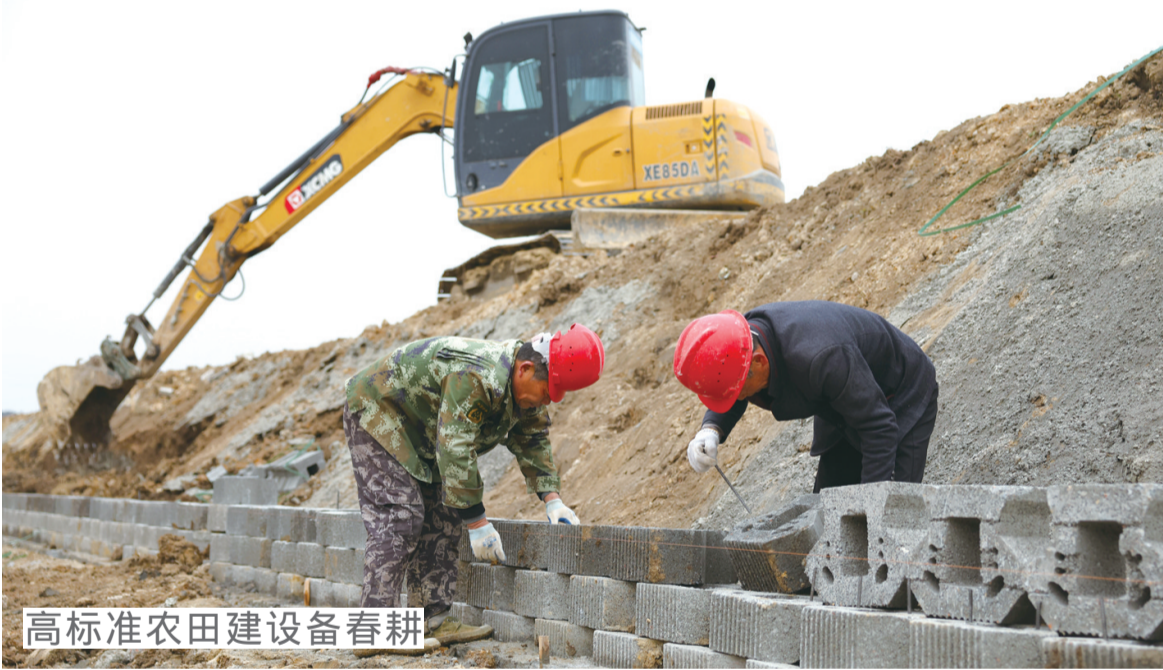
高标准农田建设备春耕 2月2日，工人在湖南省益阳市赫山区龙光桥街道五龙坝村高标准农田建设现场修建排水渠。
