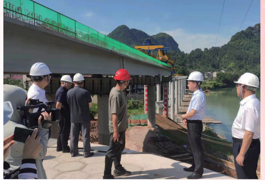
慈利县政协领导一行到溪口大桥施工现场调研。
