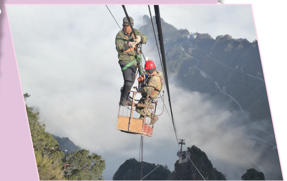
漆顺义在高空作业。
