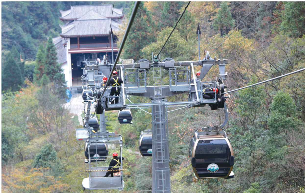
11月14日,国家客运索道安全监督检验中心按照《客运索道监督检验和定期检验规则》对武陵源景区天子山索道进行年度全面检测,确保景区索道运行安全。 吴勇兵 摄
