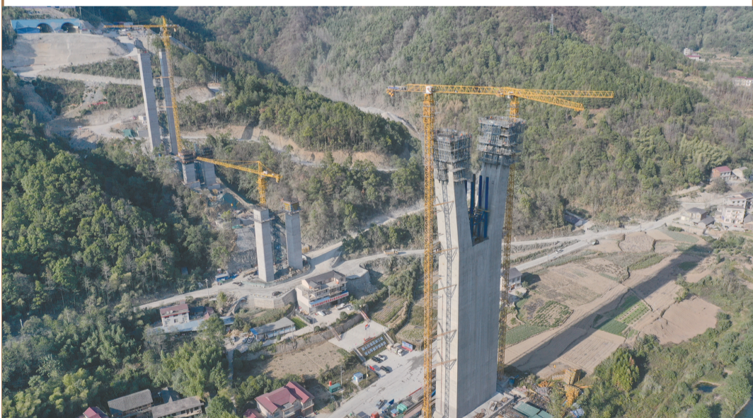
正在建设中的炉慈高速凌水特大桥。全媒体记者 邵颖摄
