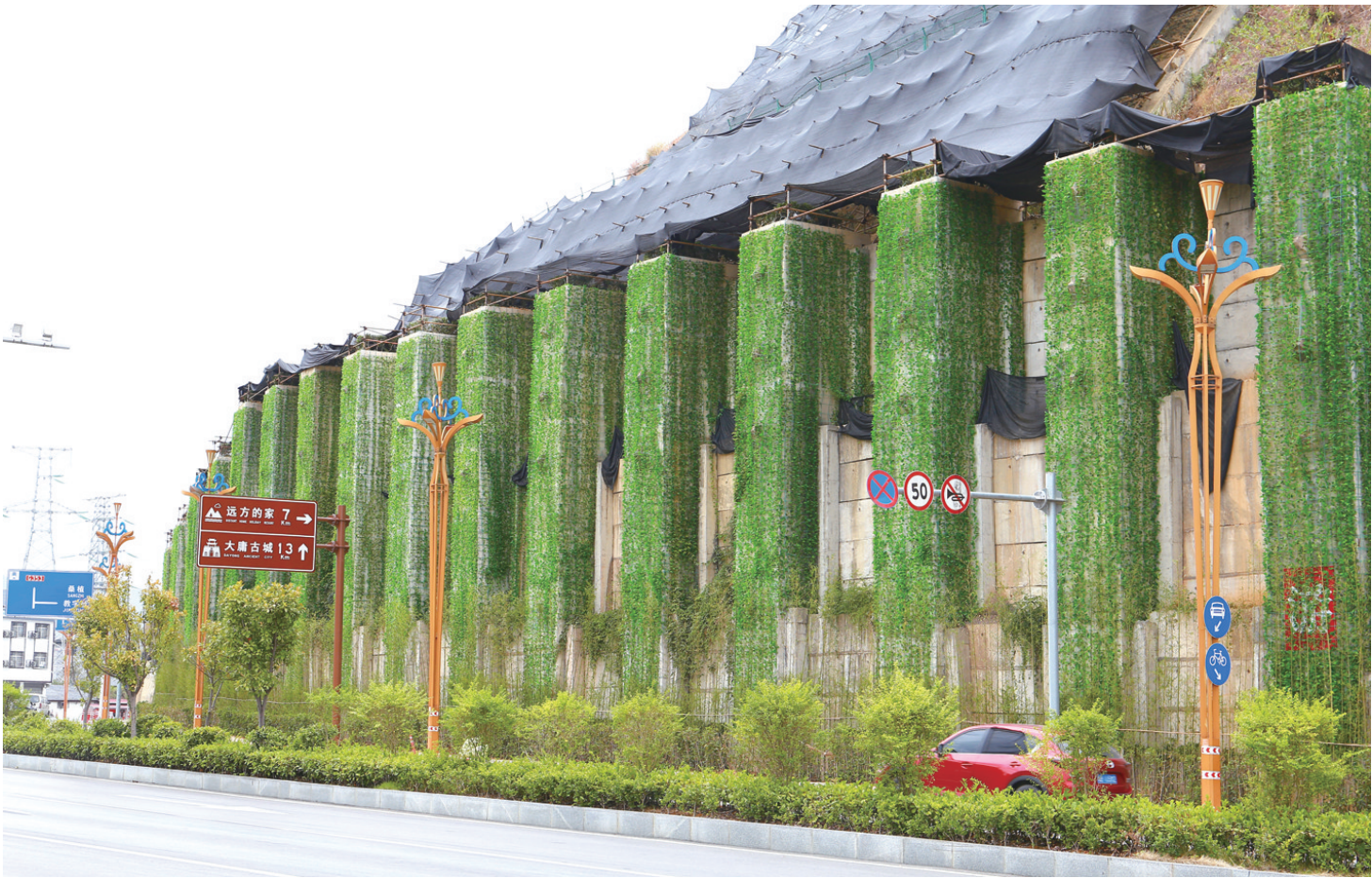
高速西出口周边被绿植装点的抗滑挡土墙。
