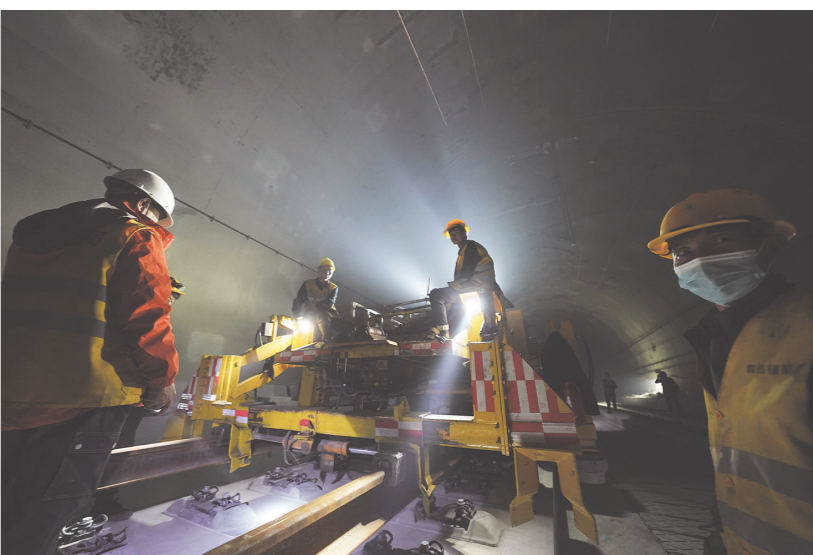
2021年3月25日,建设者在古丈隧道铺设铁轨。
