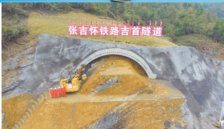
2016年12月18日,张吉怀高铁在古丈县默戎镇九龙村吉首隧道入口开工。
