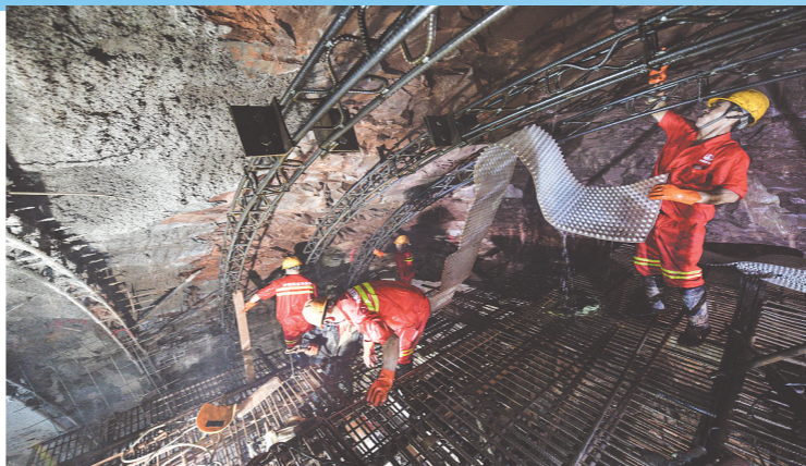
2019年7月26日,施工人员在张吉怀控制性工程吉首隧道架梁。
