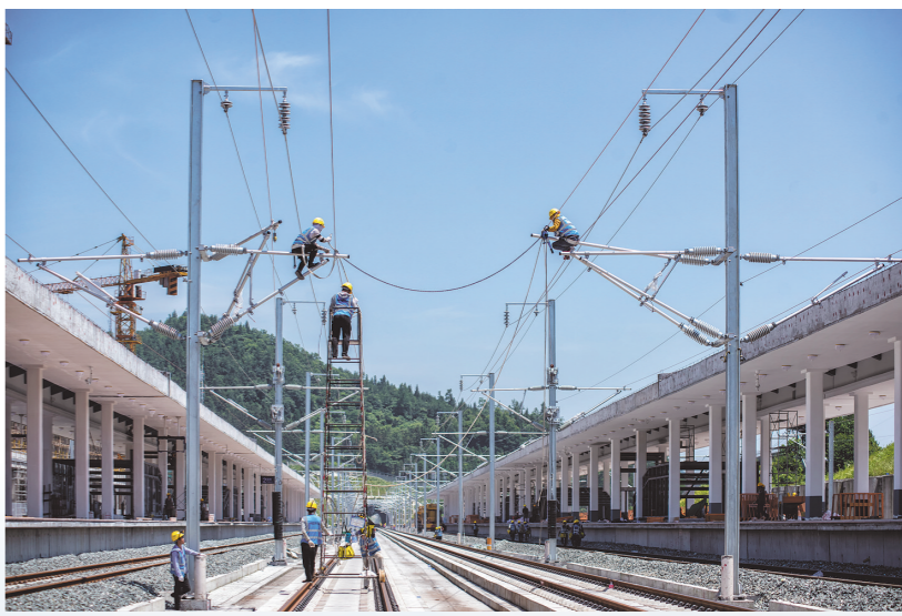
2021年6月22日,张吉怀高铁施工人员在凤凰站架设高铁高压线。
