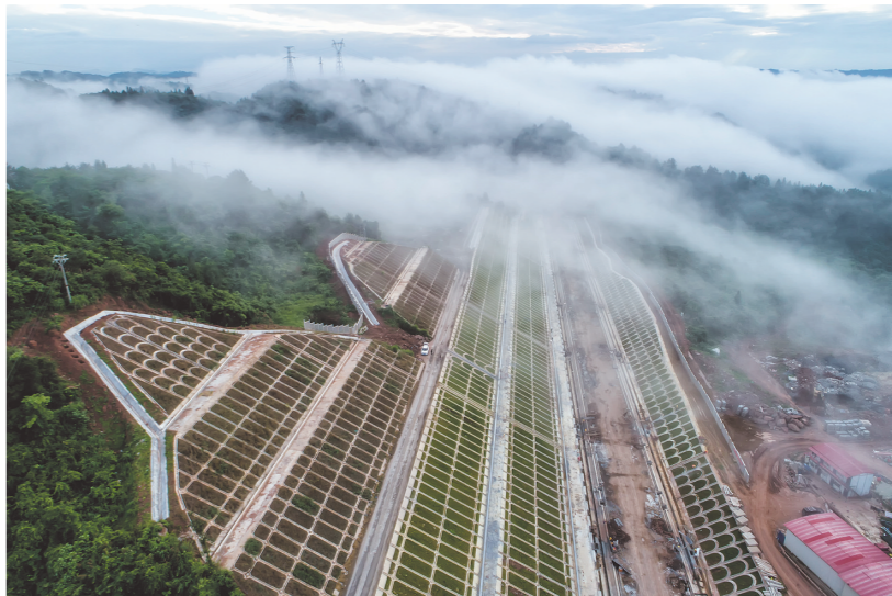
张吉怀高铁建设十分注重保护生态环境,坚持生态风貌与风土人情相结合,对边坡进行绿化处理,保证了全线 不露黄土,生态自然。图为2020年6月15日,吉首段中岩段护坡。
