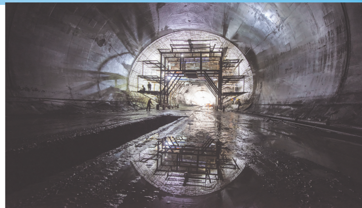
2020年6月13日,建设中的古丈隧道。
