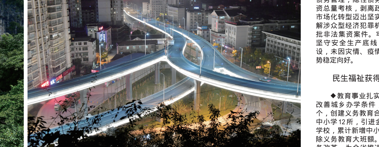
溁水大桥延伸段高架桥。
