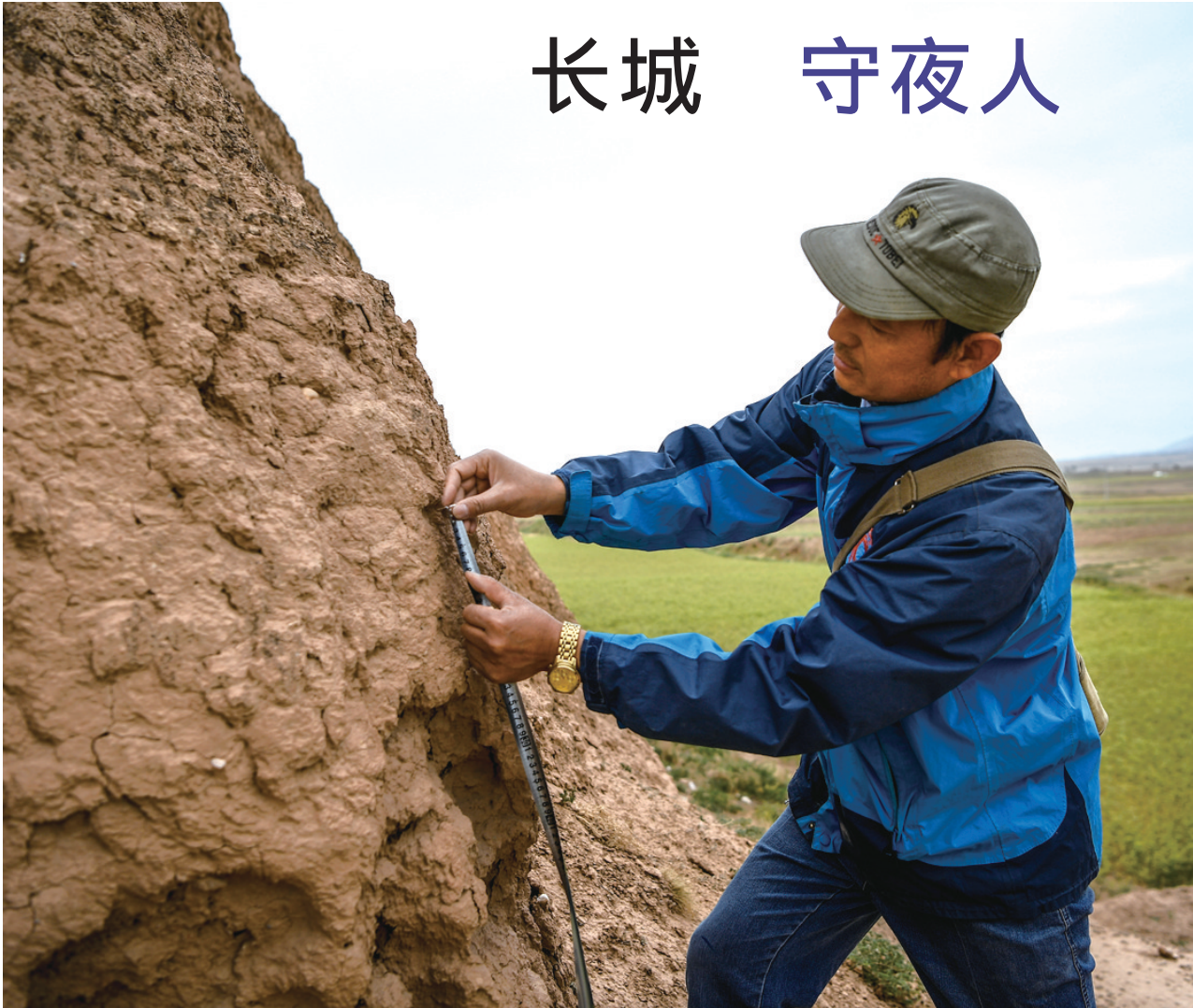
8月12日，李世翔在宁夏海原县西安州古城遗址测量墙体夯土层厚度。
