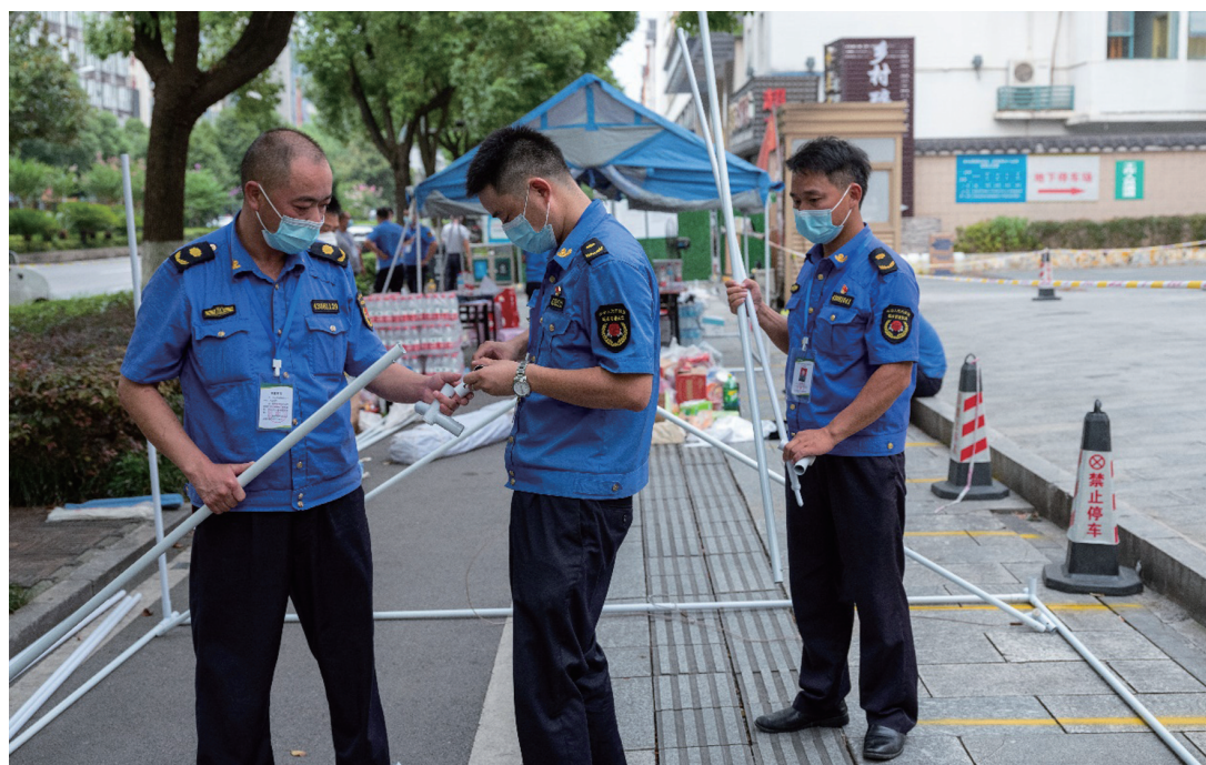
8月7日,工作人员在市区一隔离点搭建帐篷。这支由永定区城管局、永定公安分局、隔离点工作人员及市中医院医护人员组成的抗疫小分队,以帐篷为办公室,实行分组分班作业,开展隔离点值守和服务工作。彭立平摄
