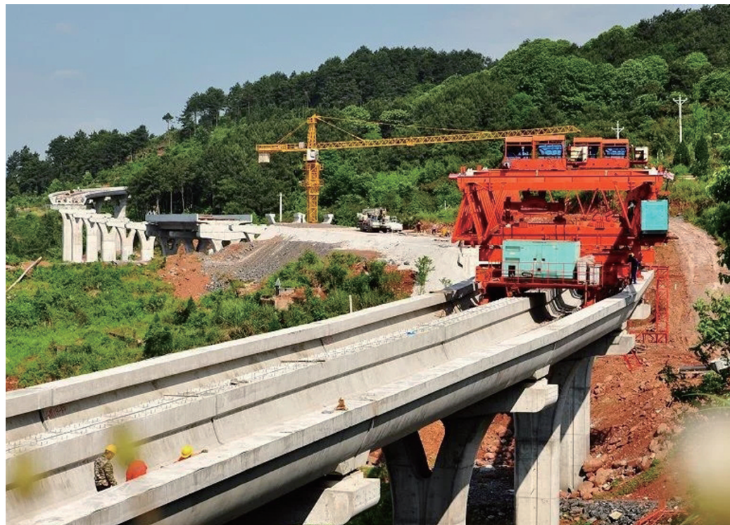
凤凰磁浮文旅项目建设施工现场，工人正在架梁施工。该项目是国内首个磁浮+文化+旅游项目和省重点工程，项目于2019年8月开工建设，全长11.2公里，一期线路9.12公里，设计时速100公里，预计年底与张吉怀高铁同时通车，并实现无缝对接。 滕建康 摄
