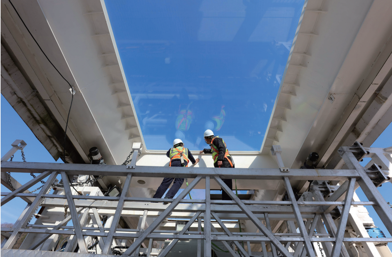
1月19日，张家界大峡谷景区玻璃桥巡检员对玻璃桥主缆索夹进行检查。寒冬时节，为保障旅游服务安全，张家界大峡谷景区加强了高山峡谷玻璃桥主缆索夹、桥梁焊缝等重点部位的检查管护力度，确保桥梁处于健康状态。 吴勇兵 摄
